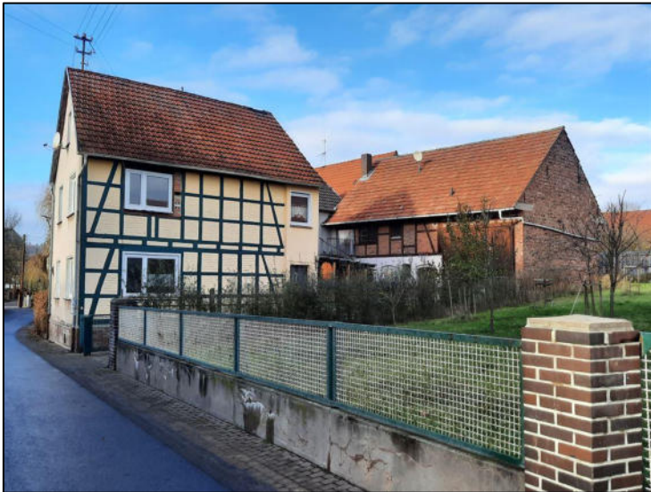
Abb. 1: Ansicht von Osten
