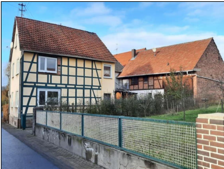
Abb. 2: Ansicht von Osten
