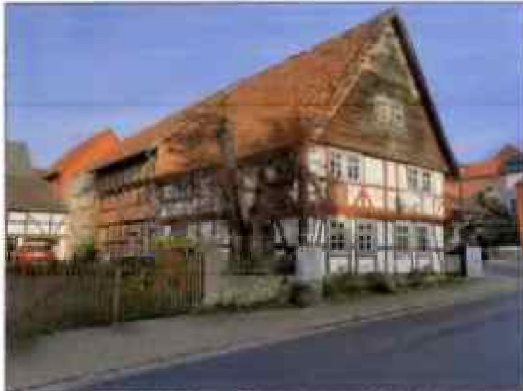
Abb. 4: historisches Wohnhaus, Westansicht und Giebelseite
