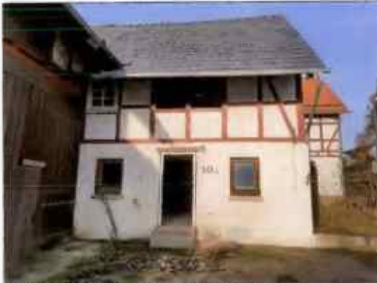
Abb. 13: ehem. Wohnhaus (Ausbau 2005), Hofseite
