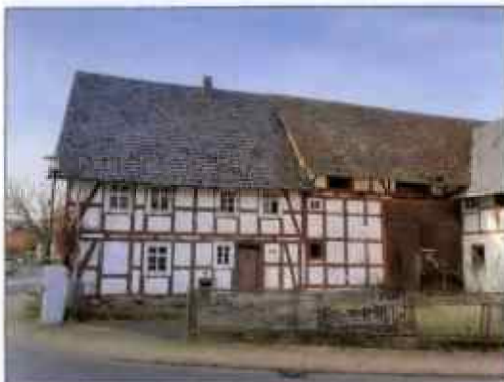
Abb. 2: historisches Wohnhaus Nr. 10 mit angebaute Scheune
