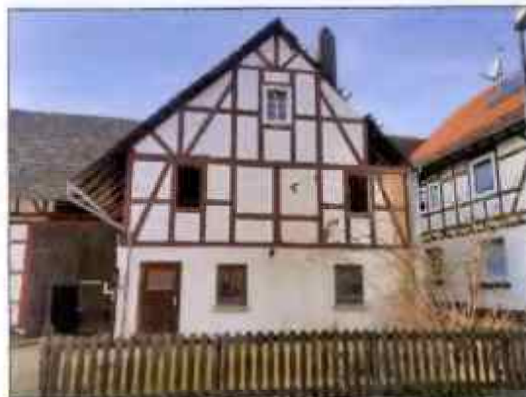
Abb. 15: ehem. Wohnhaus (Ausbau 2005), Giebelseite
