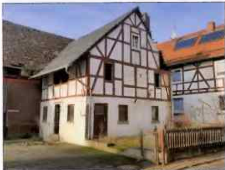
Abb. 14: ehem. Wohnhaus (Ausbau 2005), Giebelseite und Hofseite
