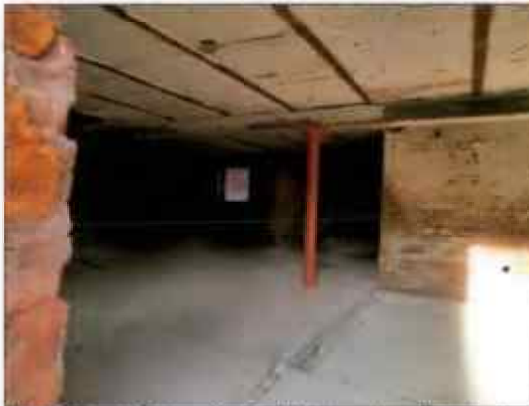
Abb. 17: ehem. Wohnhaus (Ausbau 2005), innen komplett entkernt
