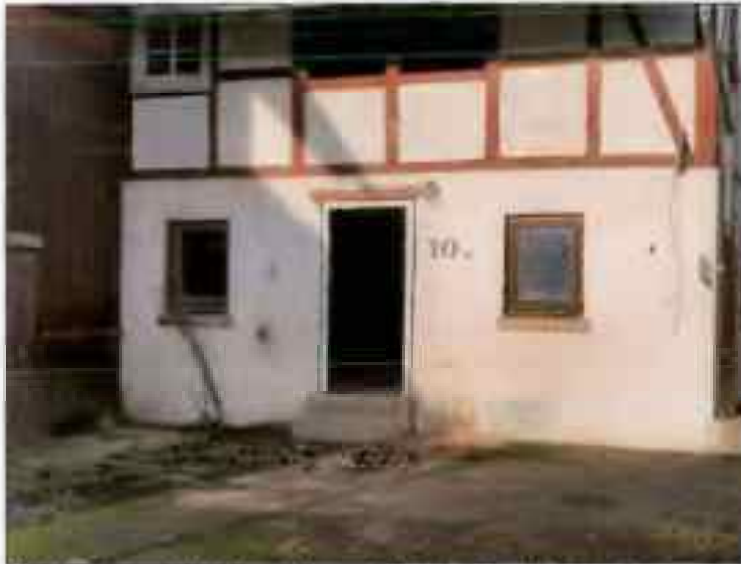
Abb. 16: ehem. Wohnhaus (Ausbau 2005), ehem. Hauseingang
