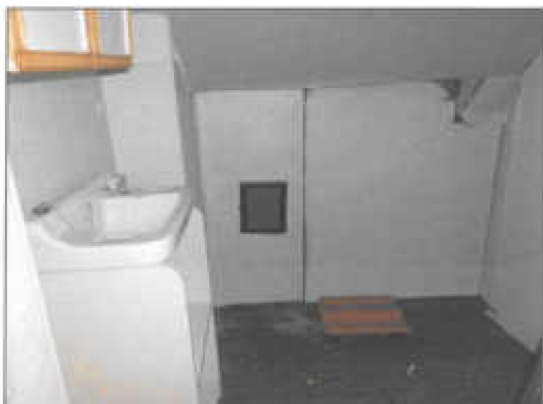
Abb. 39: Spitzboden, Raum mit Waschbecken
