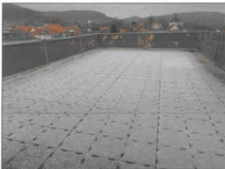
Abb. 13: Dachterasse im 1. OG
