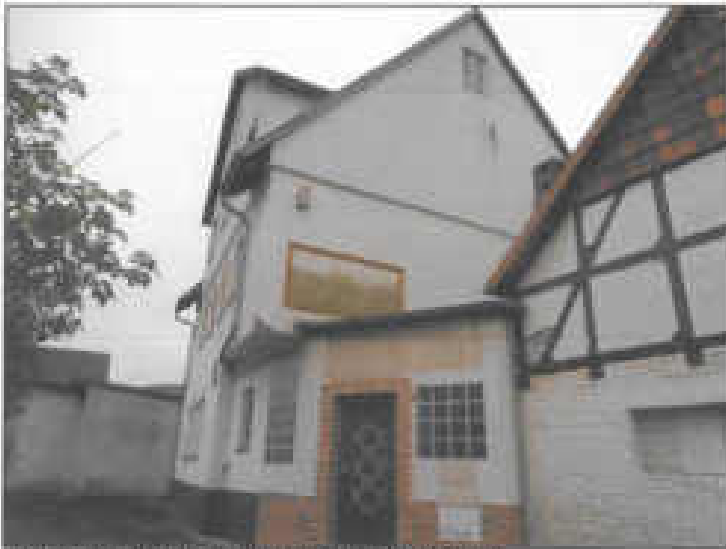
Abb. 1: Ansicht von Burgstraße von Nordosten
