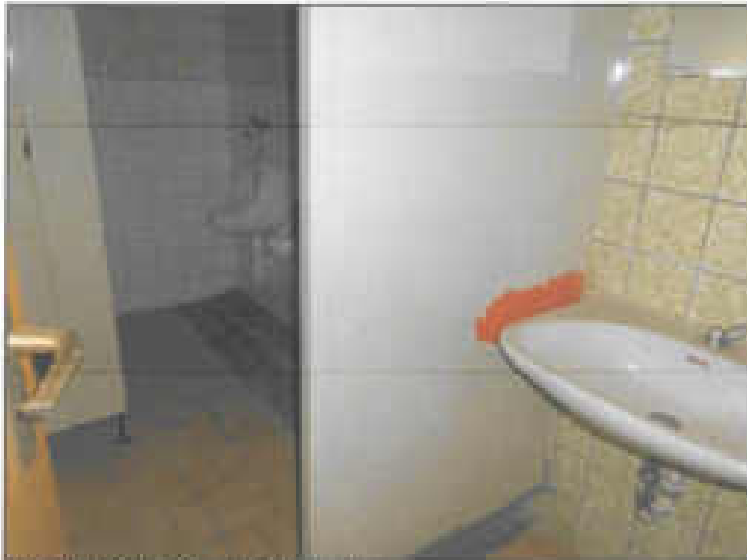
Abb. 16: Keller, ehem. Gästetoilette.
