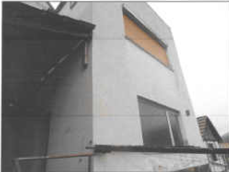
Abb. 7: Rückseite Anbau von Kellerniveau aus
