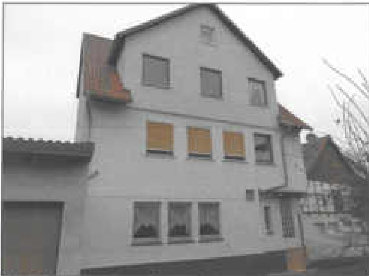
Abb. 2: Ansicht von Burgstraße von Süden
