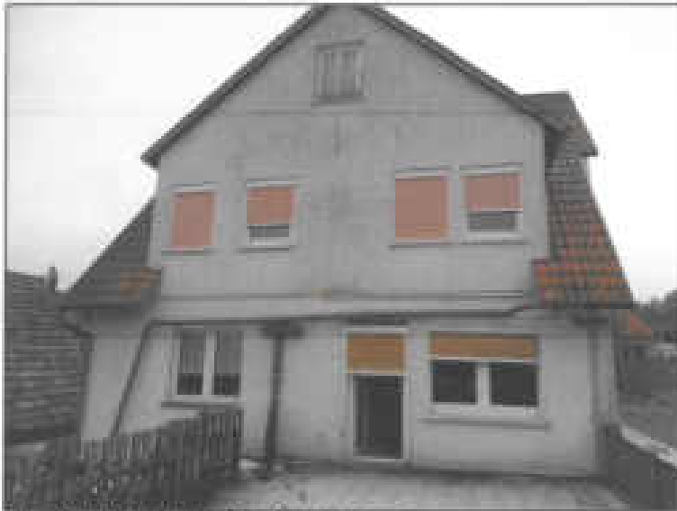
Abb. 10: Rückseite von Dachterrasse aus
