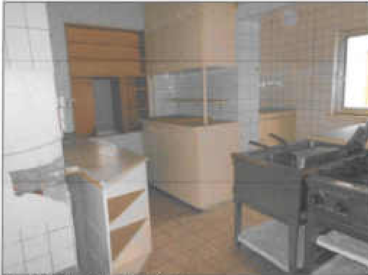
Abb. 25: Erdgeschoß, ehem. Küche
