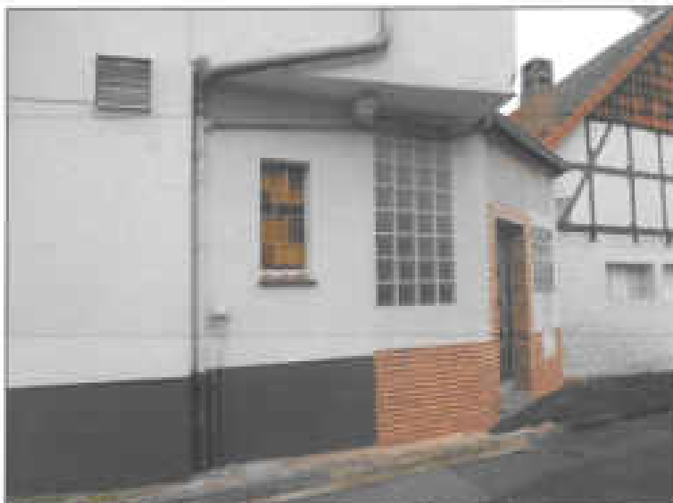
Abb. 4: Detail Straßenseite, Hausecke im OG in Straßenraum überbaut
