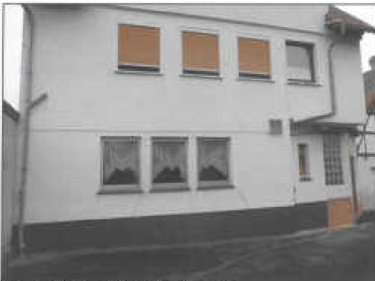
Abb. 3: Ansicht von Burgstraße von Süden
