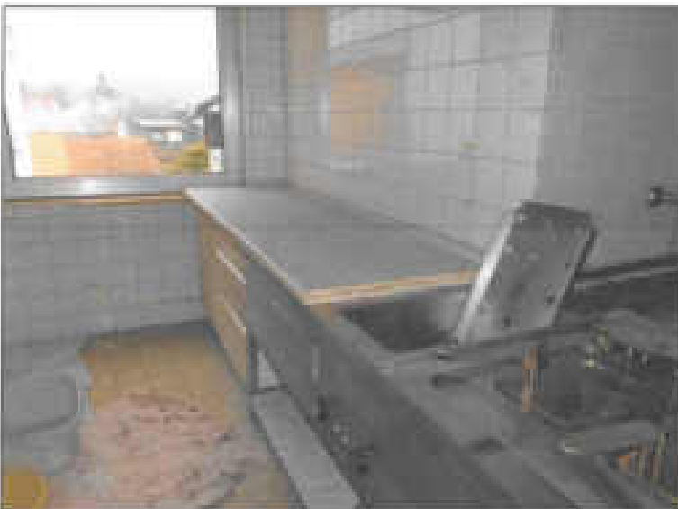
Abb. 23: Erdgeschoß, ehem. Küche
