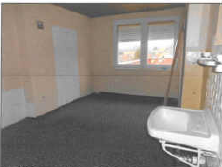
Abb. 29: Obergeschoß, ehem. Gästezimmer
