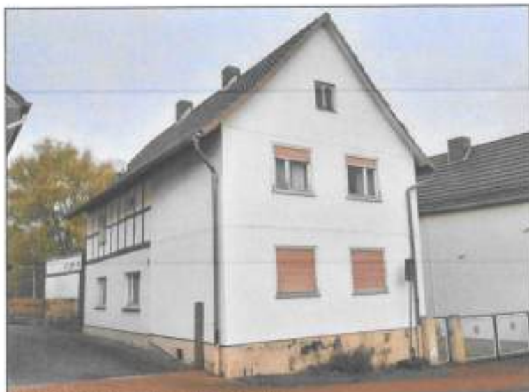
Abb. 10: Straßenseite und Westseite
