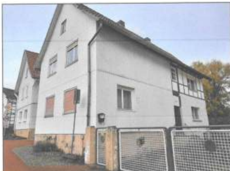
Abb. 4: Straßenansicht und Ostseite
