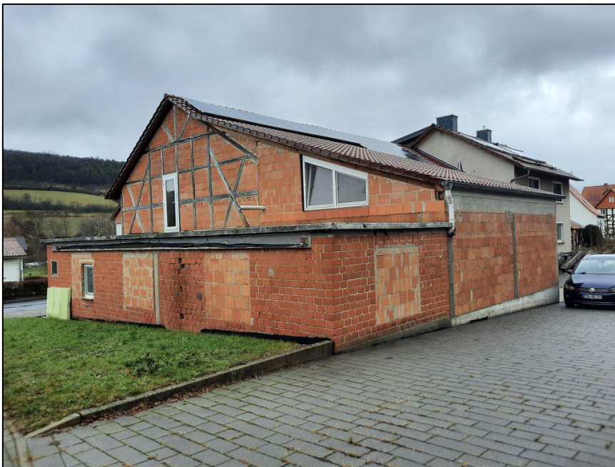
Abb. 2: TEG, Ansicht Westseite und Südseite
