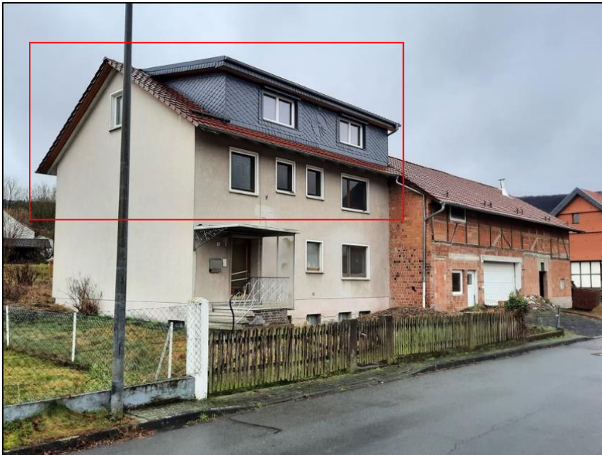
Abb. 3: Wohnungseigentum WEG, Nordansicht und Ostansicht
