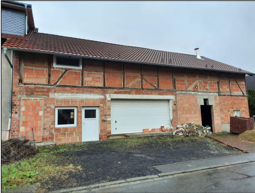
Abb. 1: Teileigentum TEG, Ansicht Nordseite
