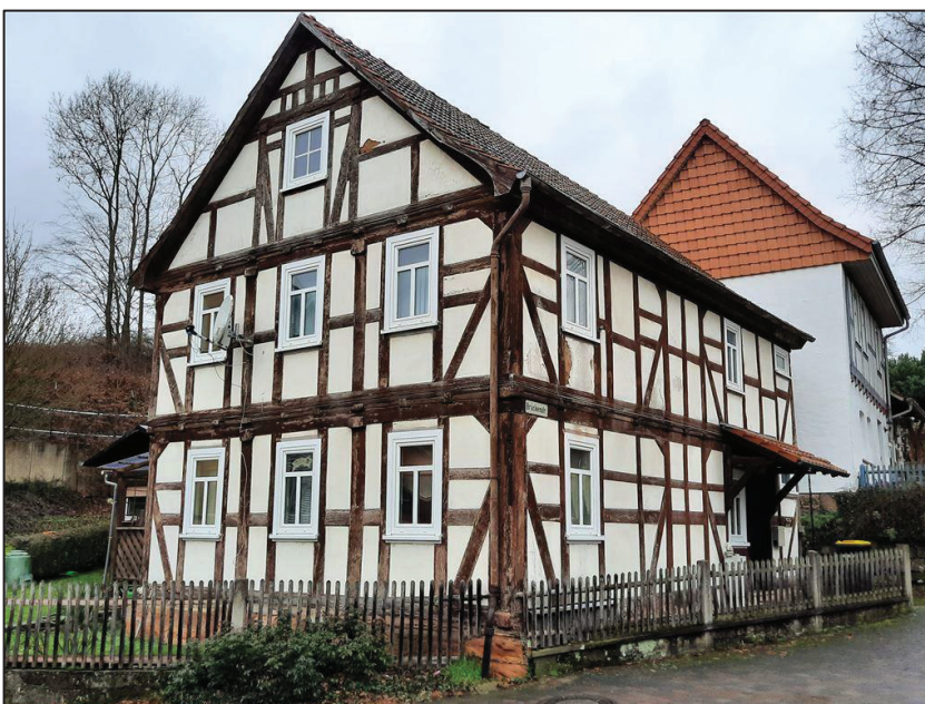
Abb. 1: Südostseite und Nordostseite
