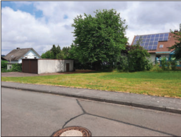
Abb. 10: Straßenansicht von Südwesten
