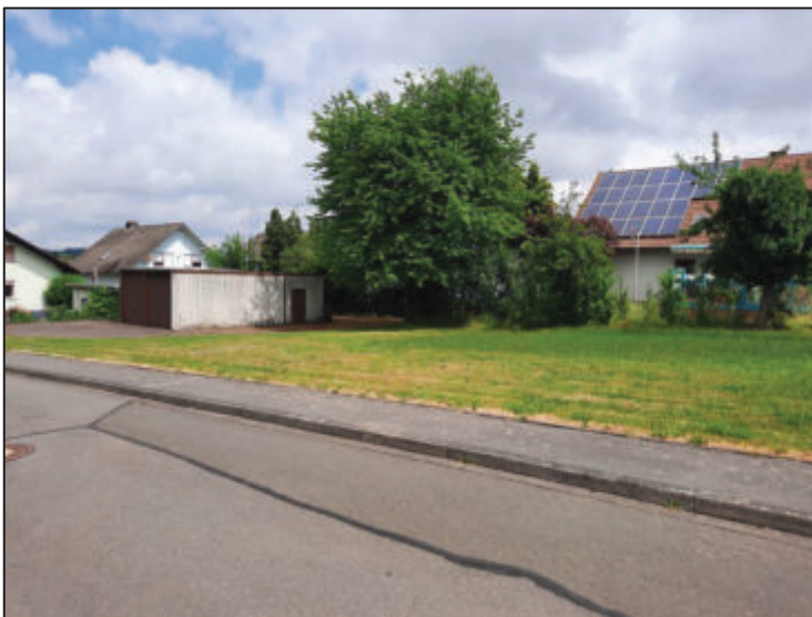
Abb. 9: Straßenansicht von Südwesten
