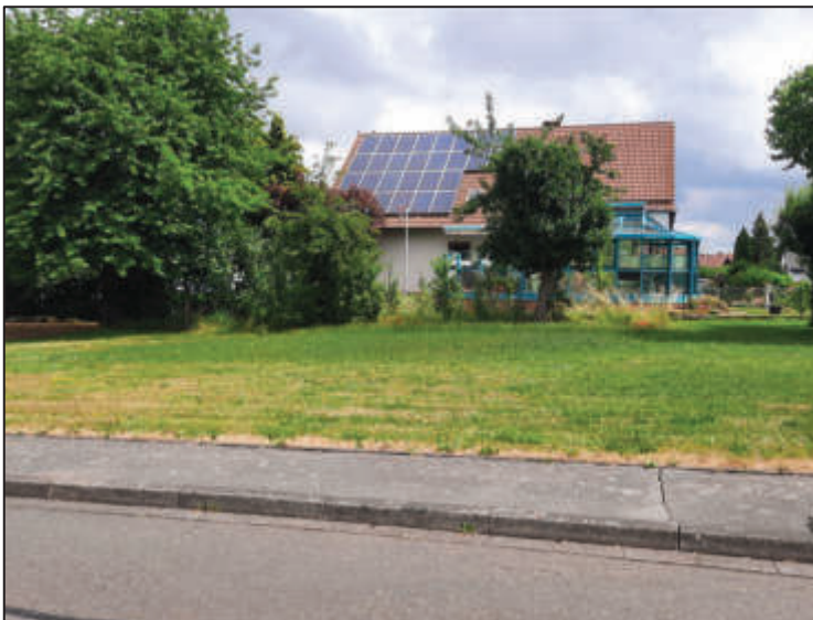
Abb. 11: Straßenansicht von Westen
