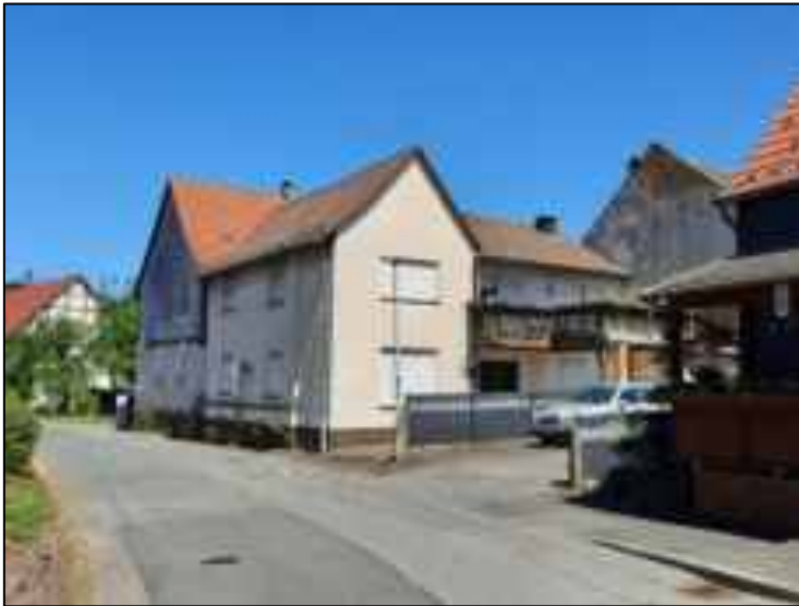
Abb. 1: Straßenansicht von Süden
