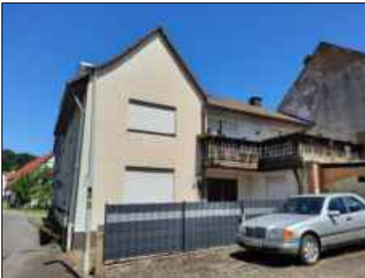
Abb. 2: Straßenansicht von Süden
