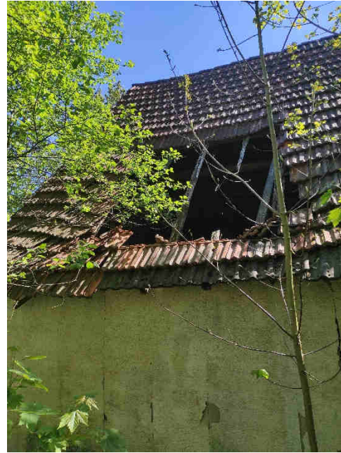
Bild 12: eingestürzte Dachflächen
