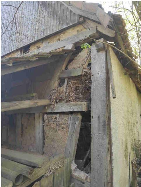
Bild 13: Eckständer aus dem Fachwerkgefüge, verschobene Wand
