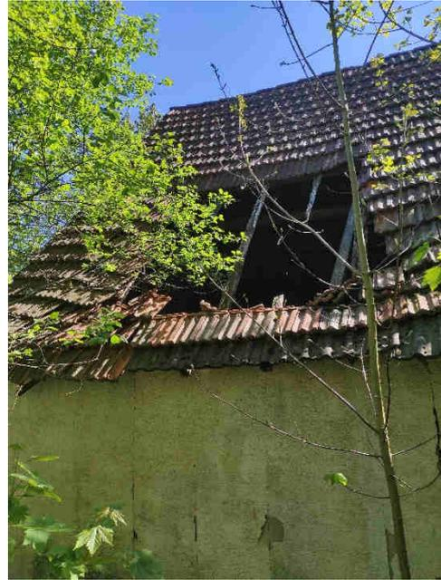
Bild 12: eingestürzte Dachflächen
