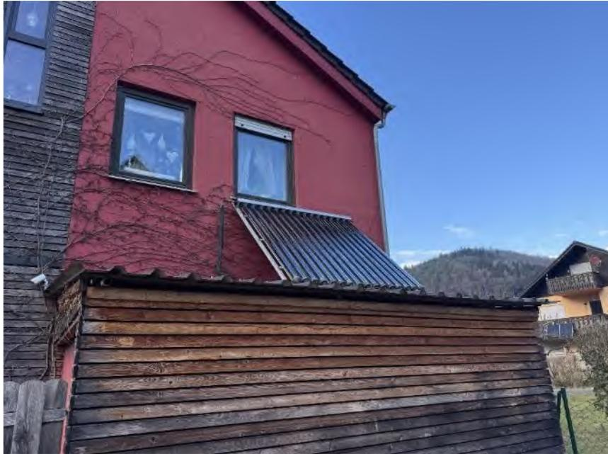
Bild 7: Solarthermie auf dem Garagendach
