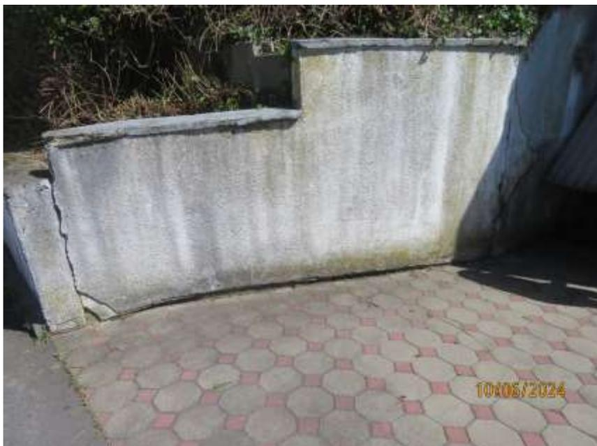
**Bild 8:** Teilansicht Stützmauer an der Zufahrt der Garage von der Gerhart-Hauptmann-Straße mit Sanierungsbedarf
