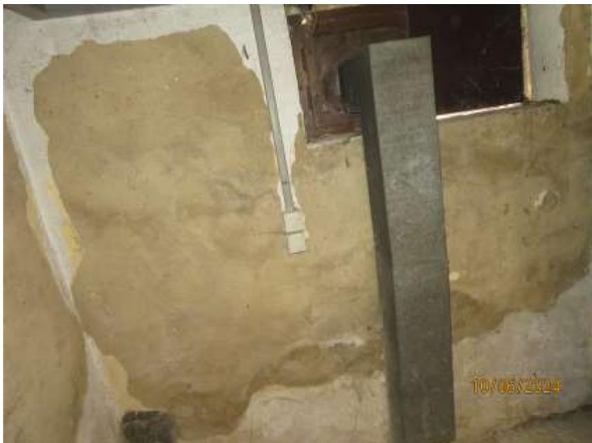
**Bild 13:** Teilansicht schadhafte Innenputzflächen im Untergeschoss
