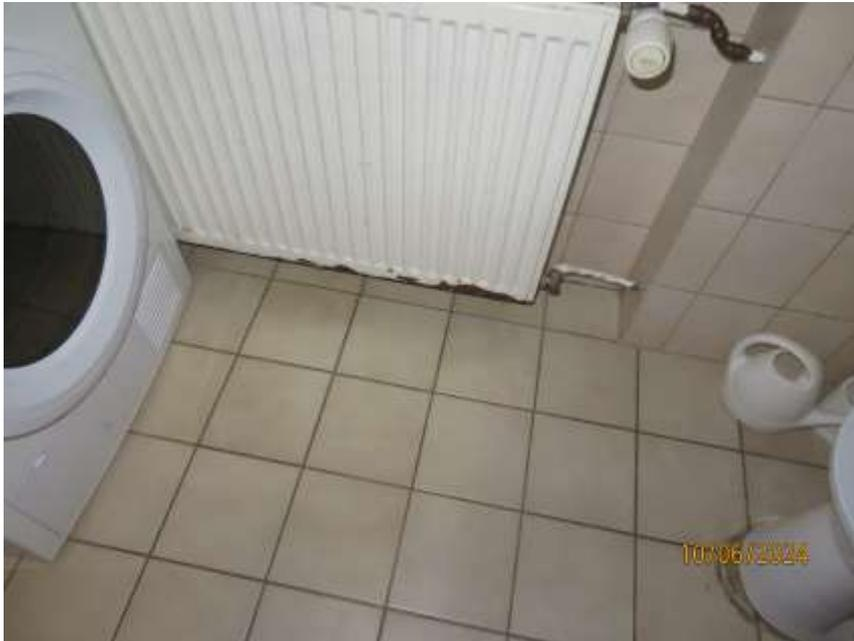
**Bild 15:** Teilansicht eines verbrauchten Heizkörpers (Rostbefall) im Bad Erdgeschoss, stellvertretend für Weitere
