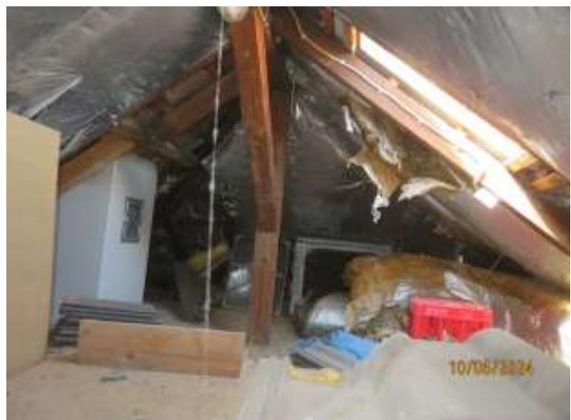
**Bild 42: Teilansicht schadhafte Dämmung im Dachraum**
