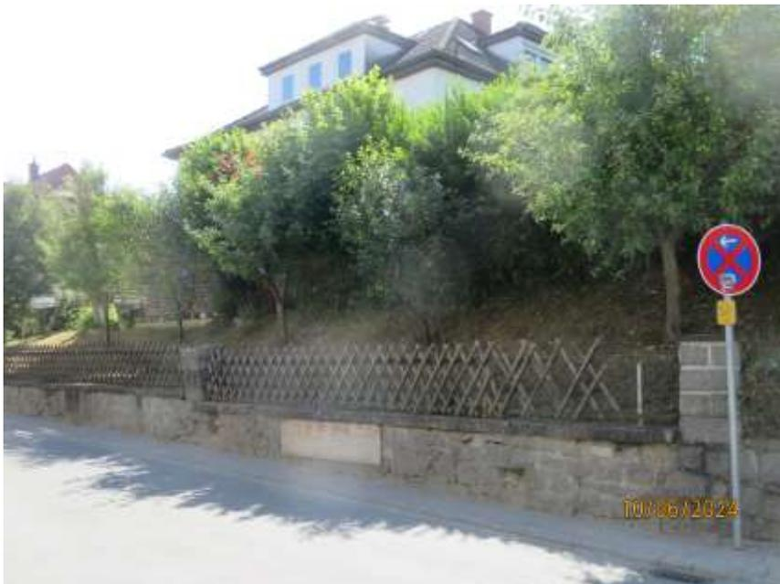
**Bild 6:** Teilansicht Einfriedigungsmauer zur Kröckelbacher Straße, teils mit erheblichem Sanierungsbedarf
