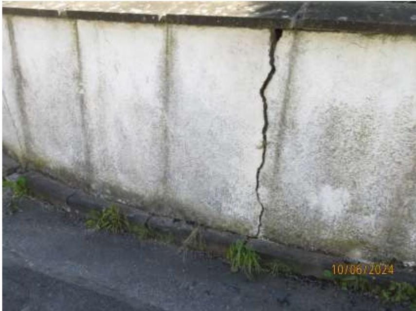
**Bild 7:** Teilansicht Einfriedigungsmauer zur Gerhart-Hauptmann-Straße, teils mit erheblichem Sanierungsbedarf
