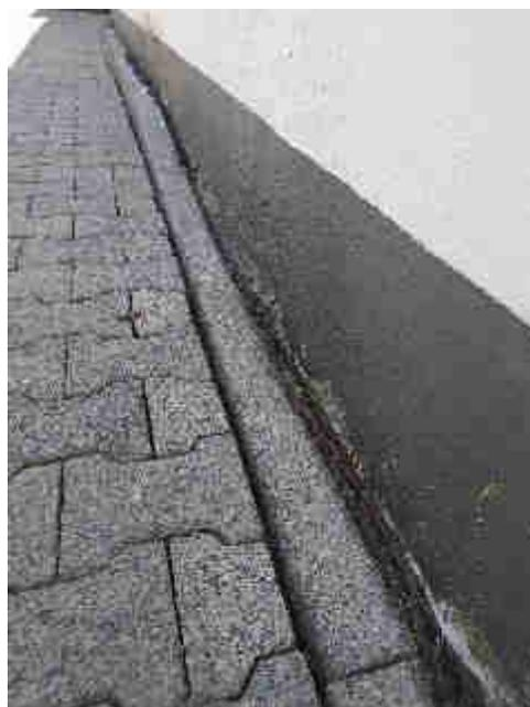
Bild 22: Geb. 2, offene Schlagregenfuge an der westlichen Außenwand
