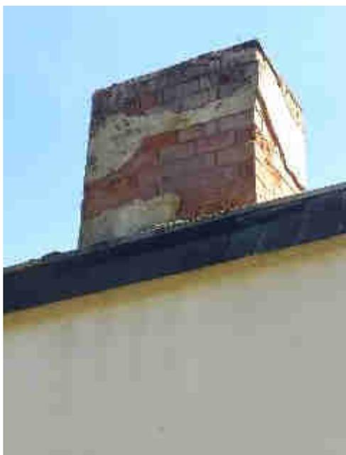
Bild 21: Geb. 2, erforderliche Kaminkopfsanierung
