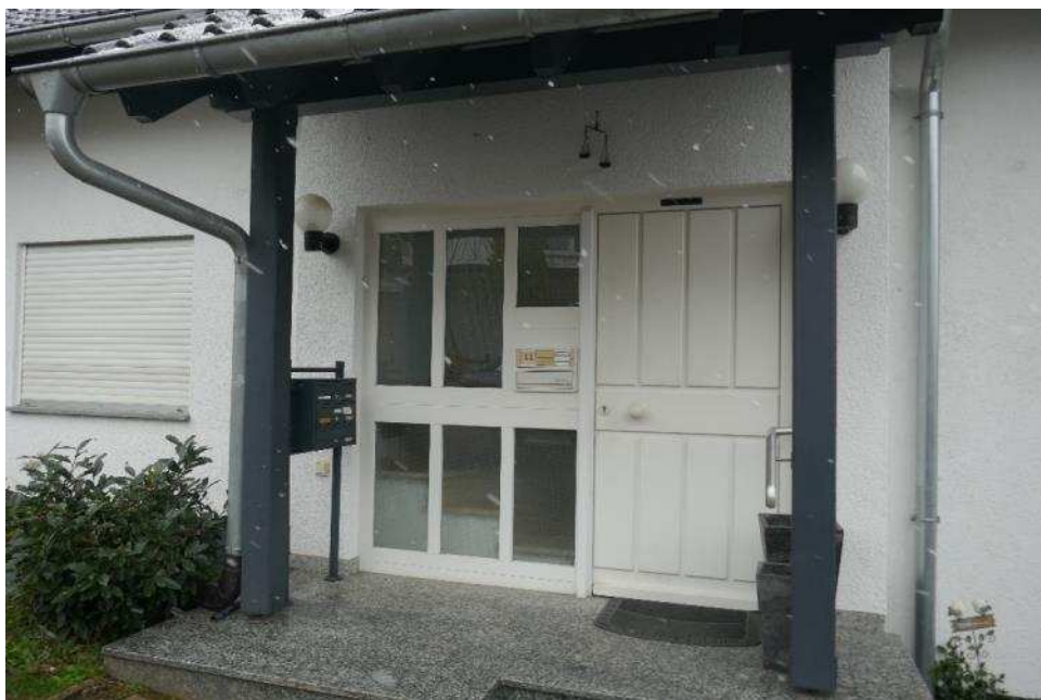
Bild 2: Eingangsbereich auf der Nordseite des Gebäudes
