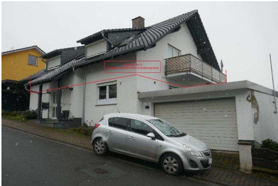
Bild 1: Außenansicht mit Blick von Nordwesten
