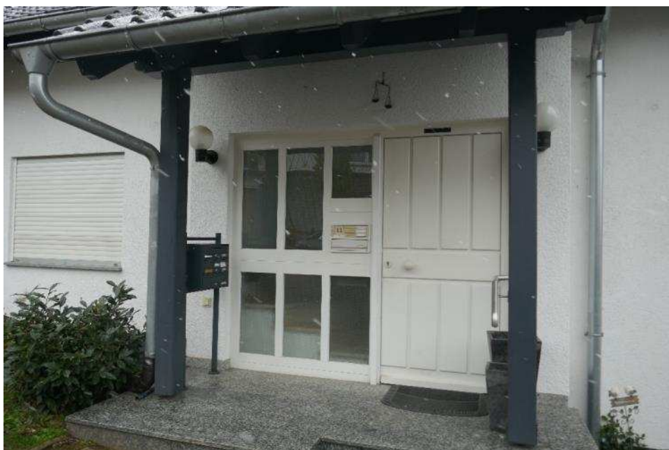
Bild 2: Eingangsbereich auf der Nordseite des Gebäudes
