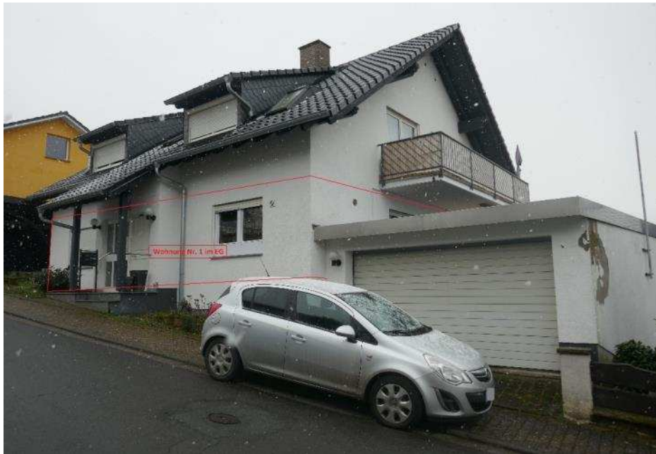
Bild 1: Straßenansicht mit Blick von Norden
