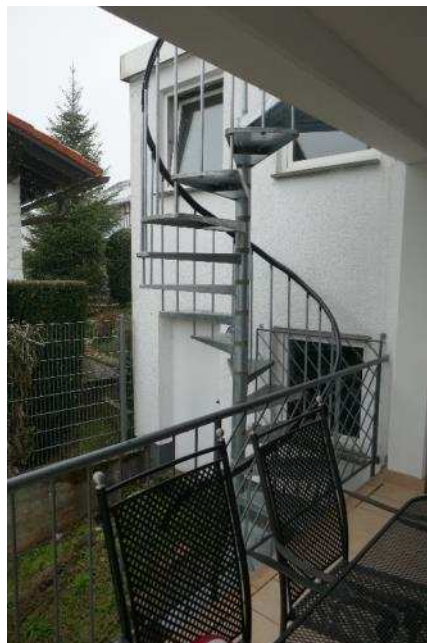
Bild 8: Spindeltreppe vom Erdgeschoss ins Kellergeschoss
