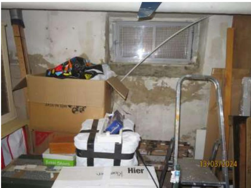
**Bild 20:** Teilansicht Feuchteschäden, stellvertretend für Weitere
