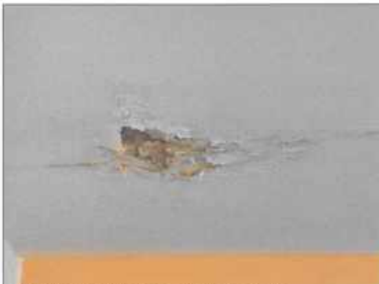
Abb. 18: Decke Schwimmbad, Feuchtigkeitsschaden
