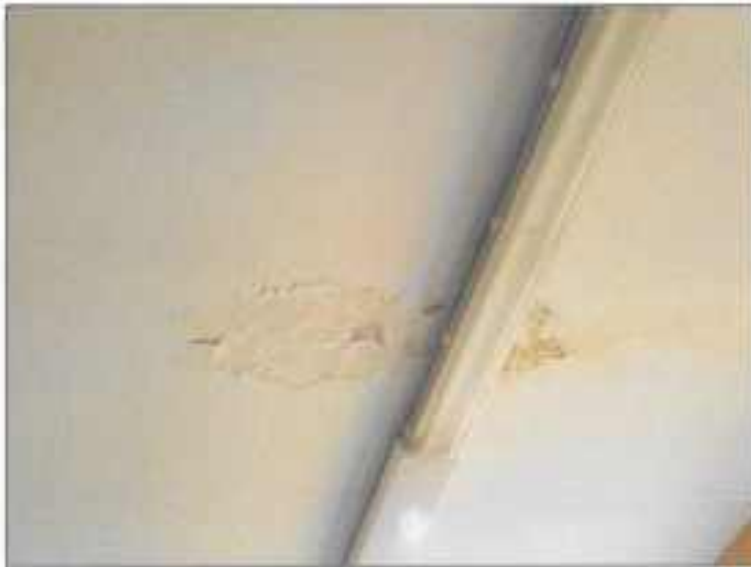
Abb. 17: Decke Schwimmbad, Feuchtigkeitsschaden
