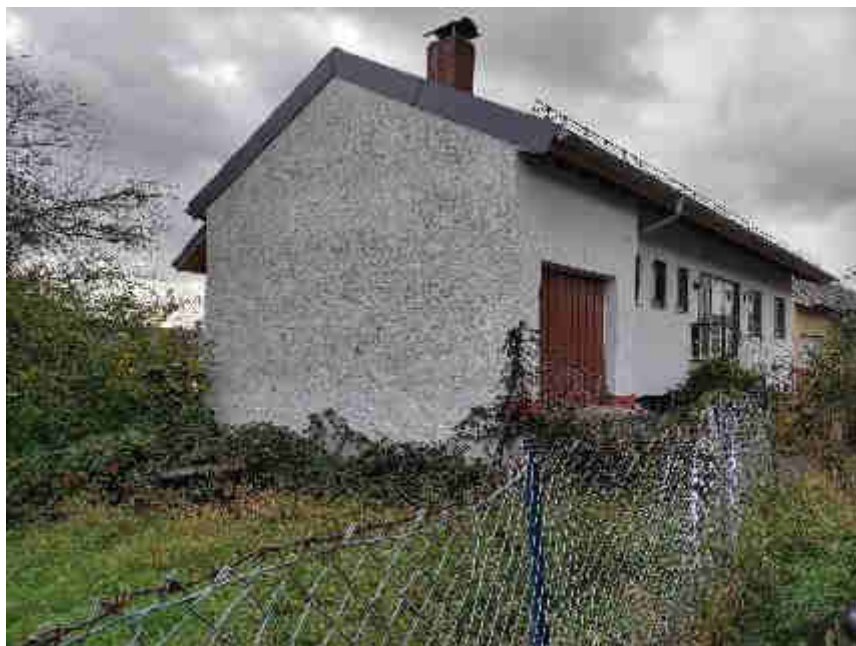
Bild 2: Ansicht nach Osten, grenzseitige Garage
