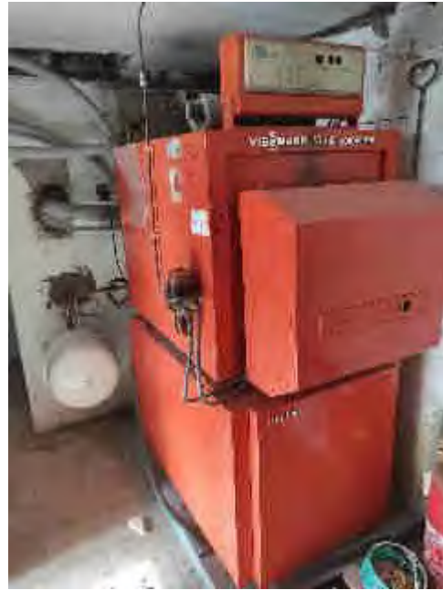
Bild 12: veralteter Ölheizkessel
