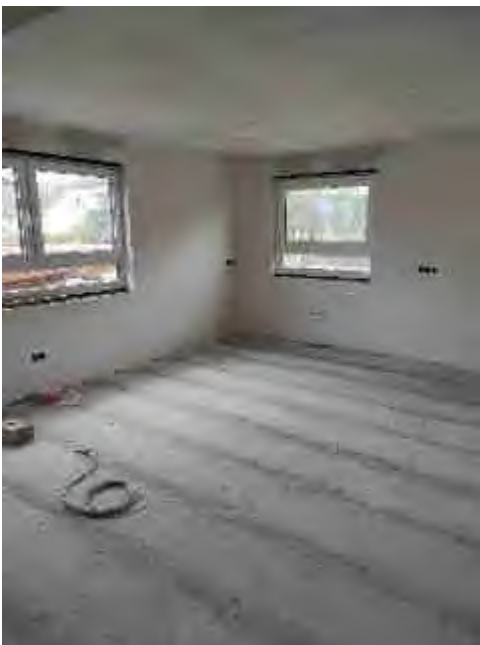
Bild 17: Blick in das Erdgeschoss
