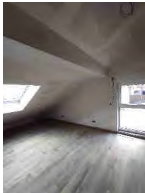
Bild 22: Zimmerausbau im Dachgeschoss, ohne Abseiten
