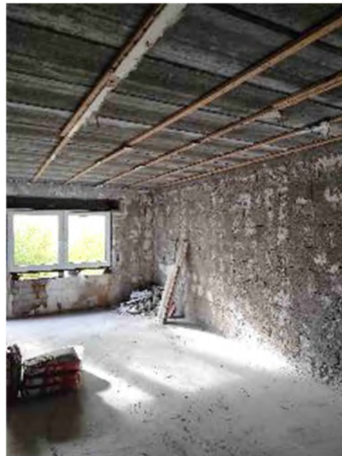
Bild 14: Rohbauzustand im gesamten Untergeschoss
