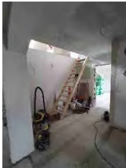
Bild 18: Diele mit Bautreppe
