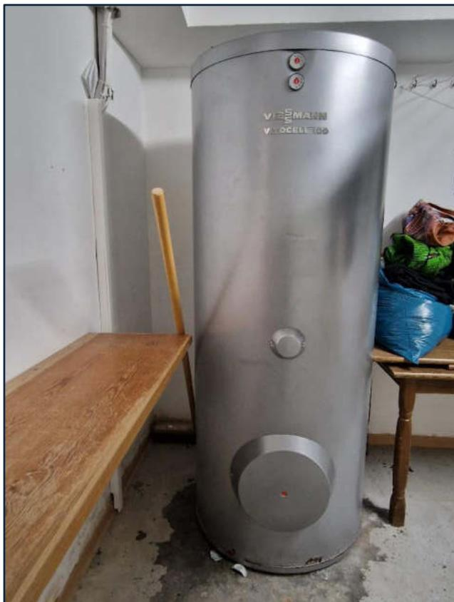
Foto 6: Warmwasserspeicher zur Heizung Viessmann 2002
