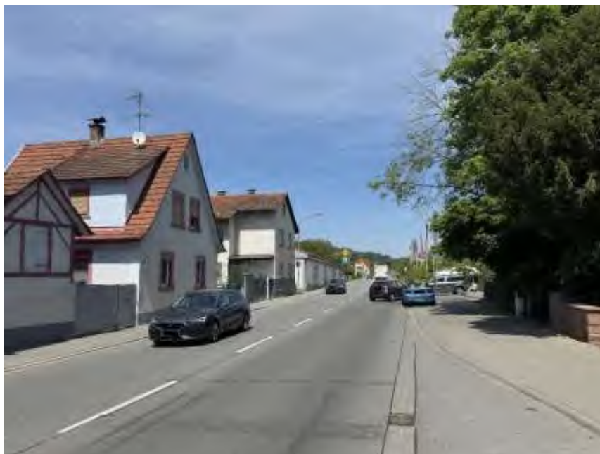
Bild 22: Umgebungsbebauung an der Erbacher Str. mit Blick nach Norden
