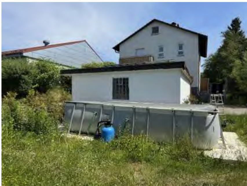
Bild 4: Gebäudeansicht von Westen
