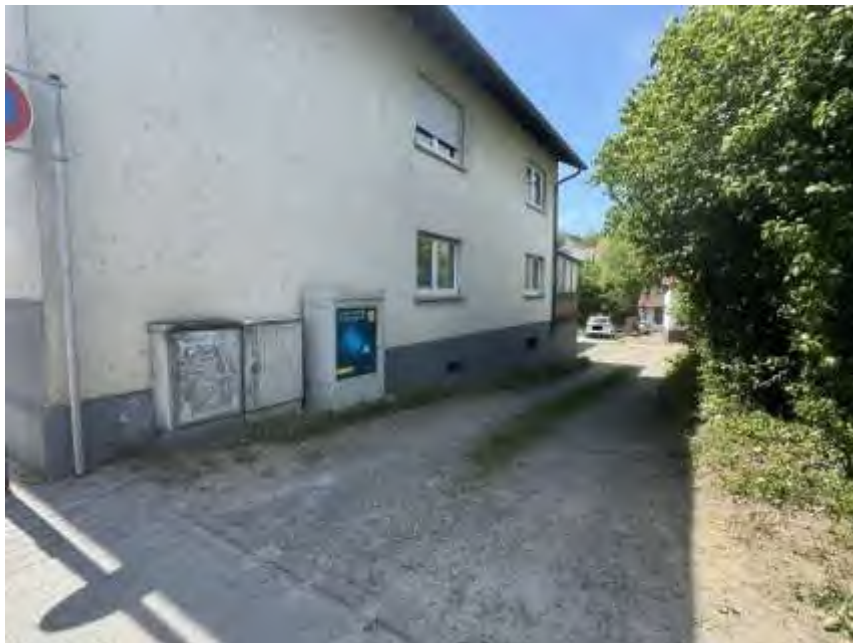
Bild 18: Zufahrt (öffentlicher Weg) zu Garage und Stellplatz von der Straße
