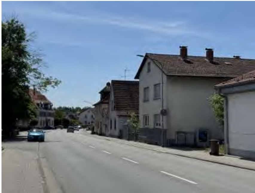
Bild 21: Umgebungsbebauung an der Erbacher Straße mit Blick nach Süden
