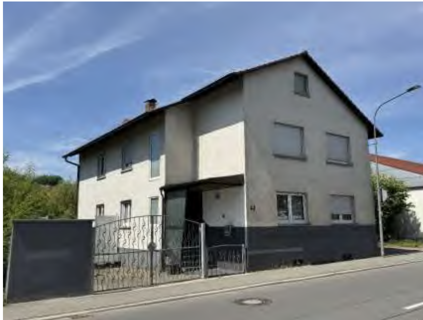
Bild 1: Gebäudeansicht von Südosten
