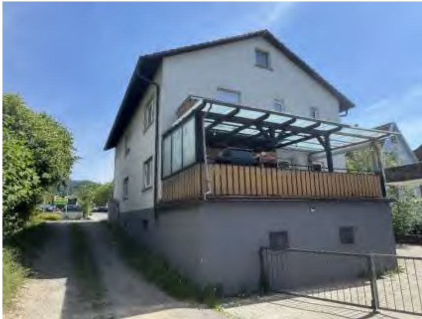
Bild 3: Gebäudeansicht von Nordwesten
