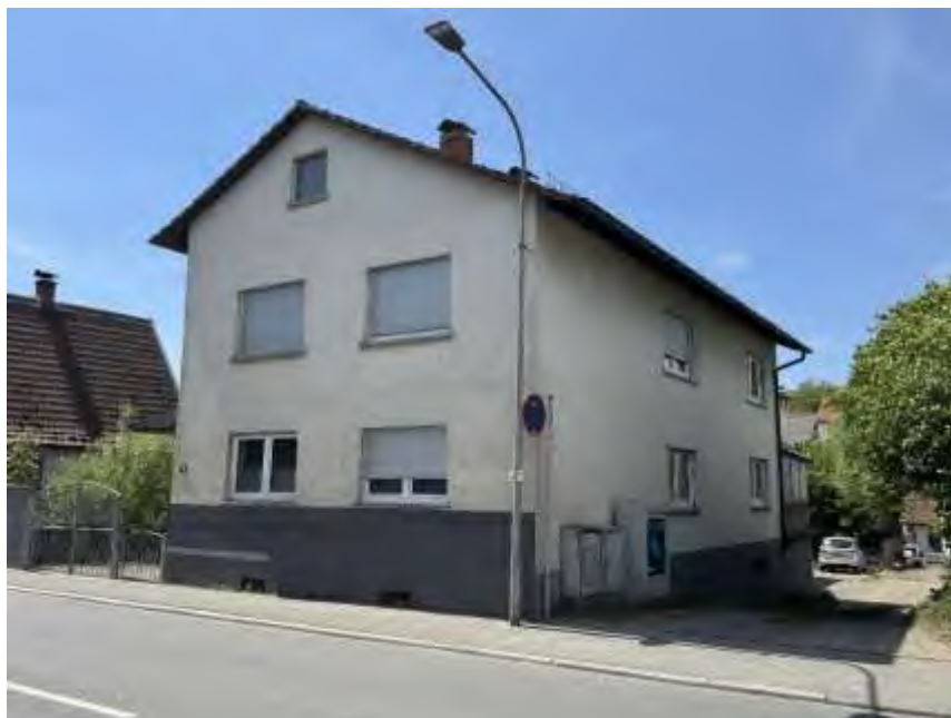
Bild 2: Gebäudeansicht von Nordosten
