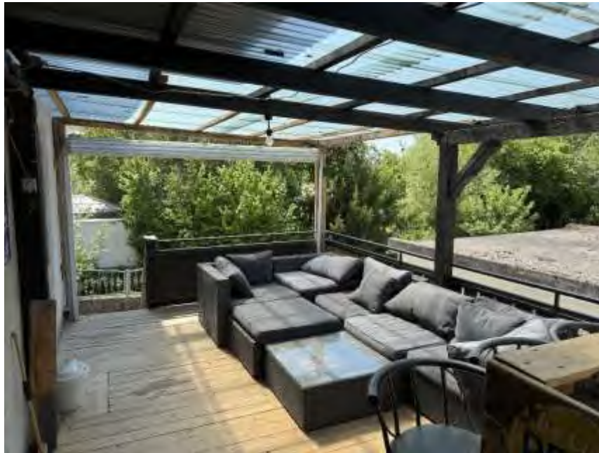
Bild 11: Veranda an der Gebäude-Westseite
