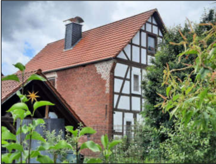
Abb. 4: Wohnhaus von Landstraße aus
