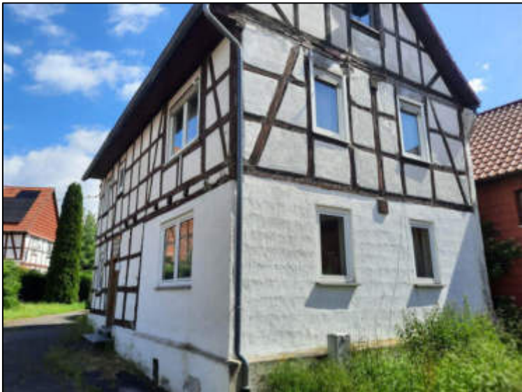
Abb. 11: Wohnhaus von Schulstraße aus, Eingangsseite und Giebelseite
