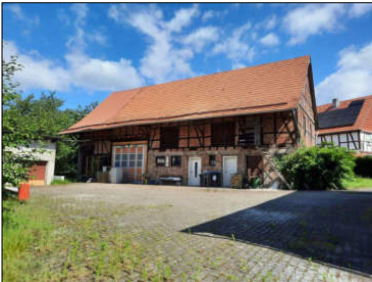
Abb. 8: Hof und Scheune
