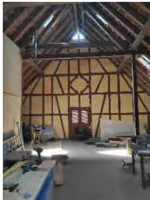
Bild 20: Blick in den Scheunenraum Geb. (5)
