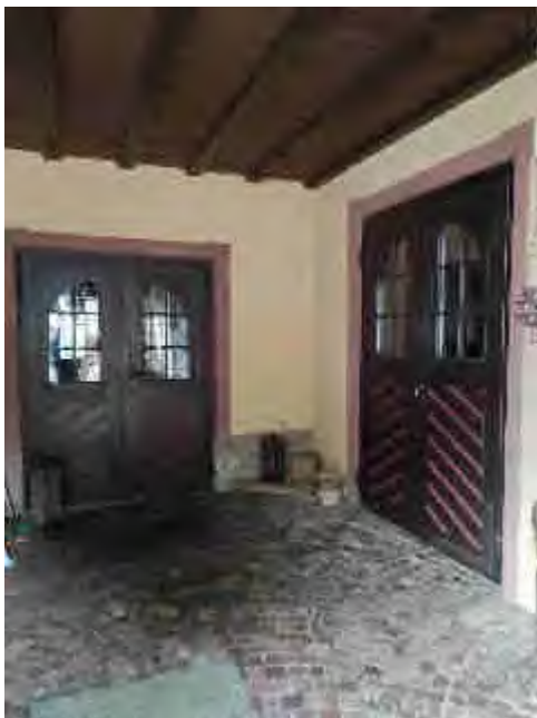
Bild 19: Vorhalle am Wohnungseingang Geb. (4)
