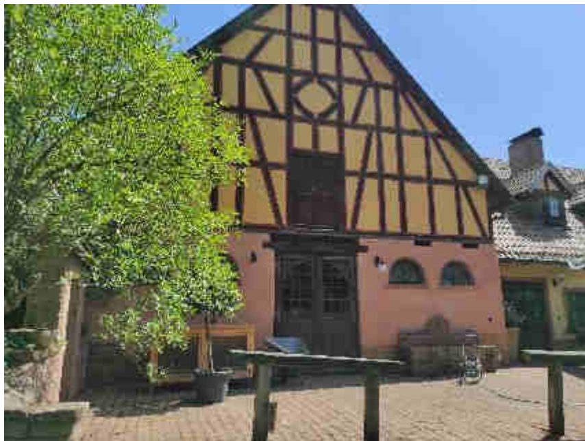
Bild 10: Südwestansicht Hofgebäude m. Stallung (5)
