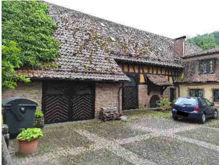
Bild 3: Ansicht Hofgebäude m. Stallung (5)
