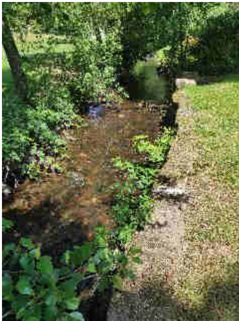
Bild 17: Grundstücksbefestigung am Ulfenbach
