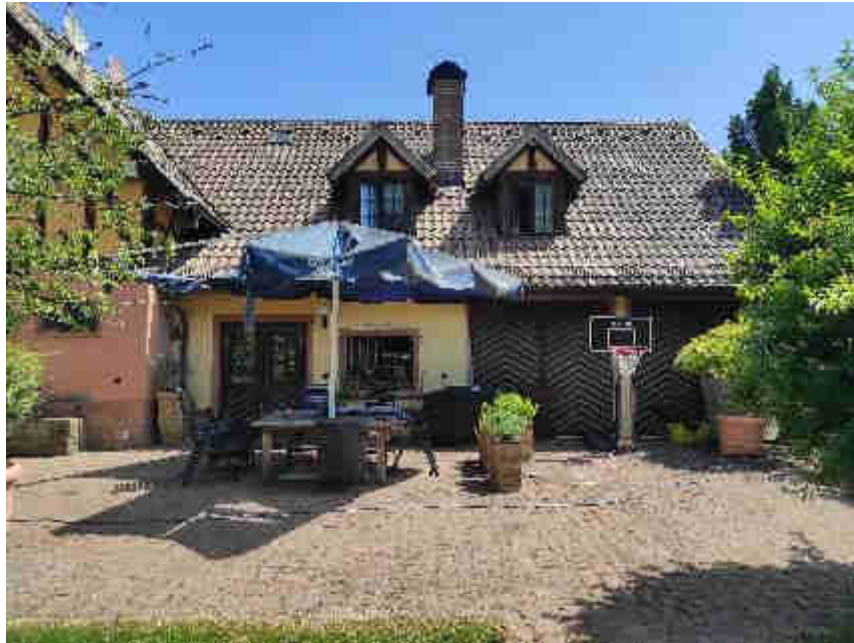
Bild 11: Südwestansicht Wohn- und Garagengebäude (4)
