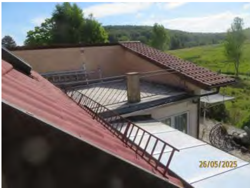
Bild 10: Teilansicht zu dem rückwärtigen Balkon mit Dachaufsicht zu dem unbeheizten Wintergarten
