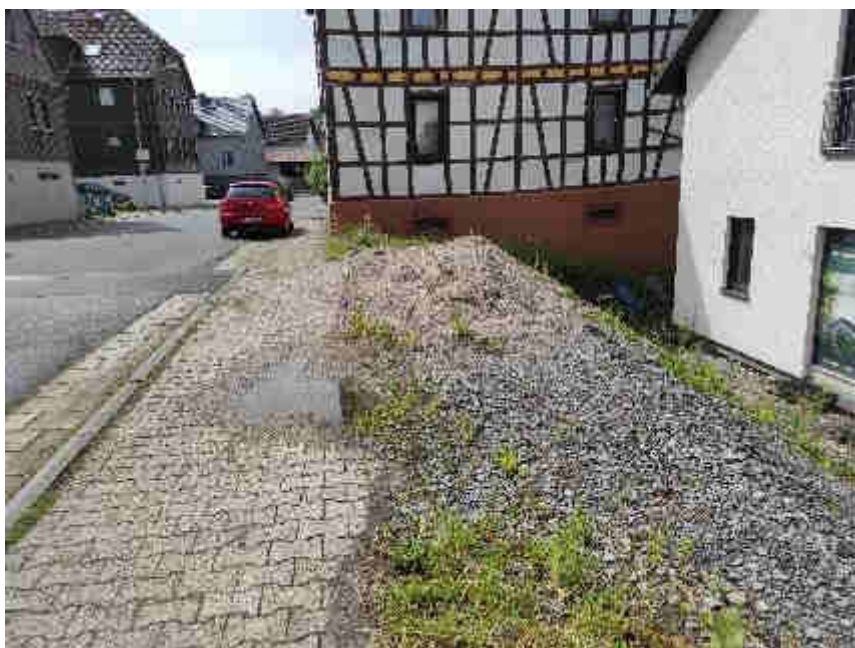
Bild 4: Höhenniveau zwischen Gehweg und Hauseingang
