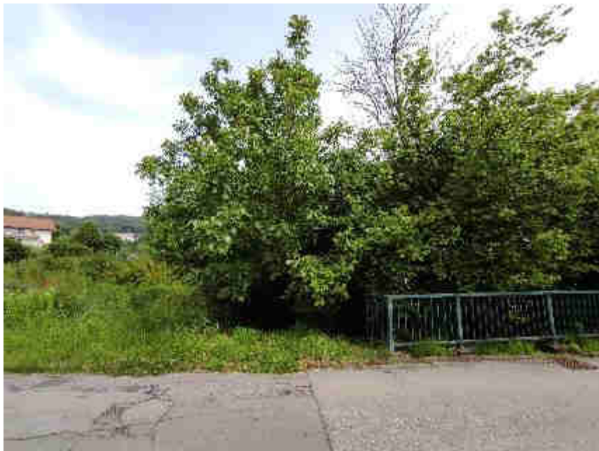
Bild 10: Gersprenzbrücke am Grundstück 229/2
