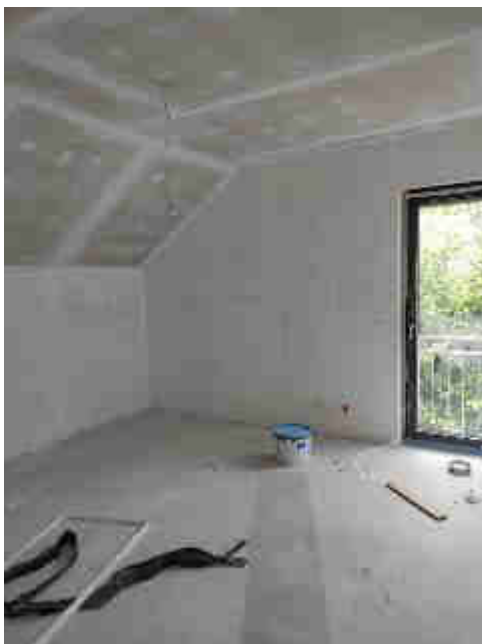
Bild 17: Zimmer im Dachgeschoss
