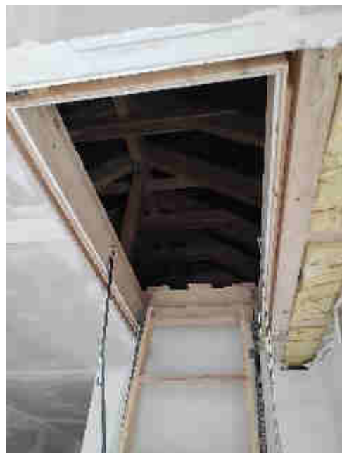
Bild 18: Einschubtreppe zum Spitzboden
