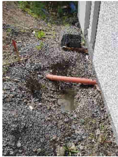
Bild 12: unfertige Entwässerungsleitungen
