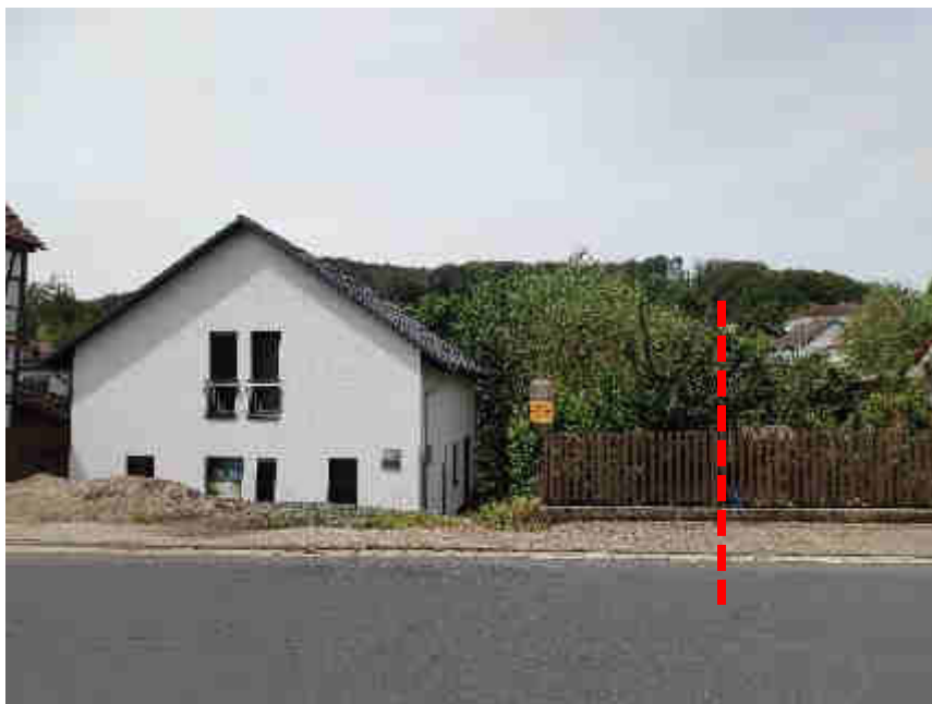
Bild 2: Ansicht entlang des Gehweges, Grenzverlauf rechts
