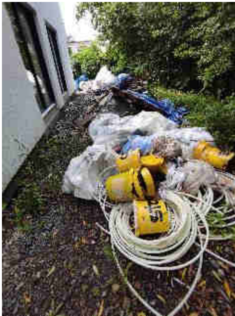
Bild 11: gelagerter Bauschutt um das Wohnhaus
