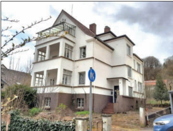
Abb. 2: Nordwestansicht und Nordostansicht
