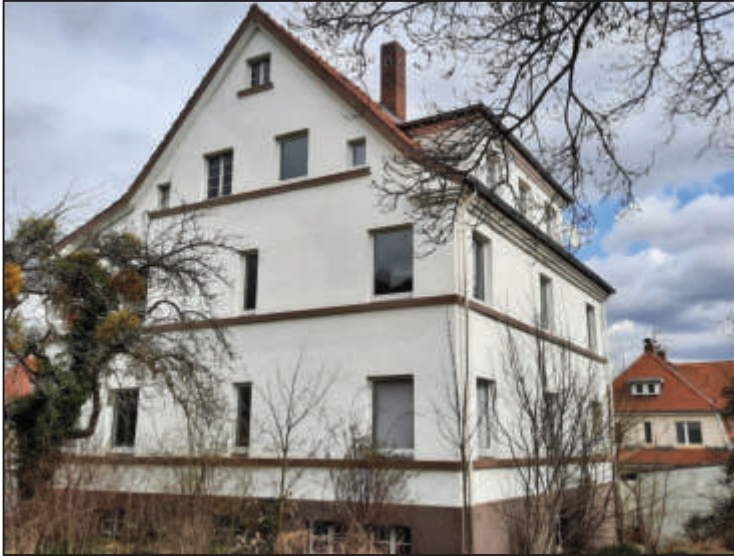
Abb. 4: Südwest- und Südostansicht
