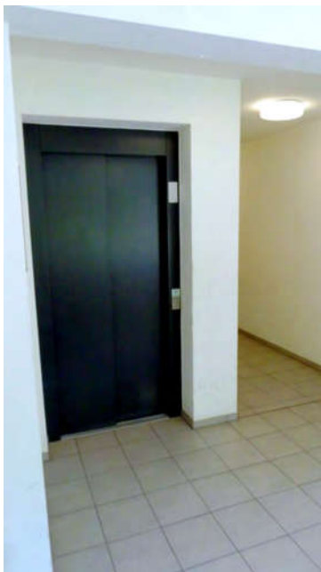
Bild 15: Treppenhaus Bereich Aufzug
