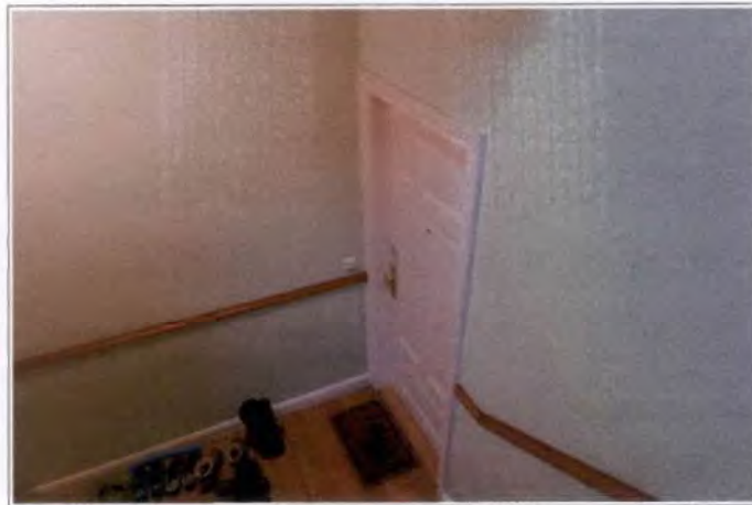
Bild 4: Treppenhaus, Eingang ETW 15
