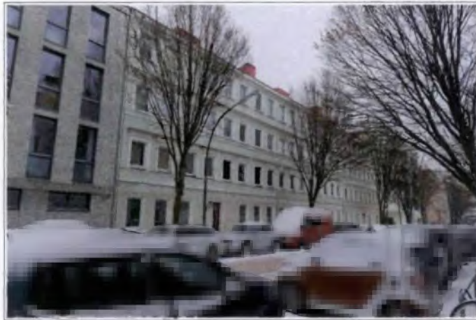
Bild 1: Ansicht Nordwest, Geibelstr. 26 - 30
