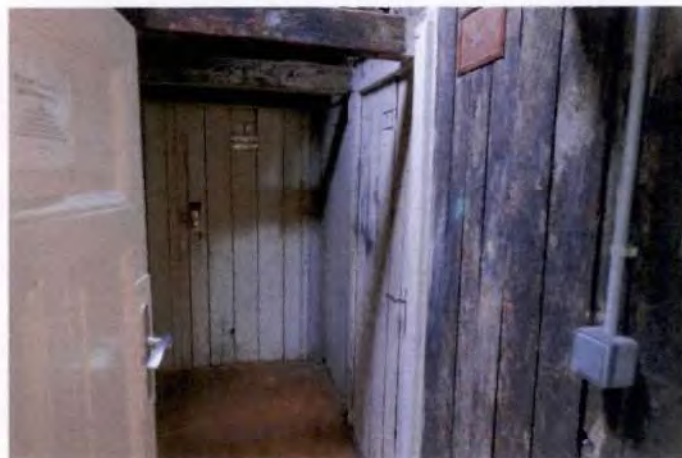
Bild 5: DG – Zugang zu den Abstellräumen
