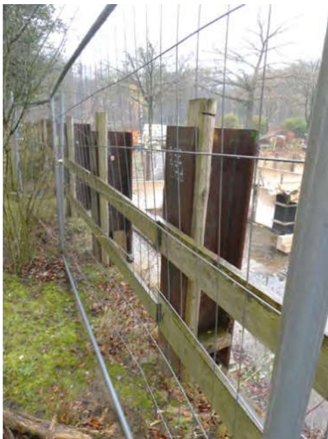
Bild 19: Baugrubenverbau / Einzäunung Grundstück
