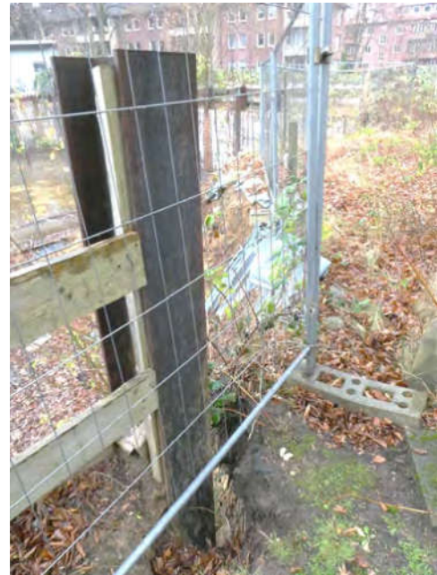
Bild 18: Baugrubenverbau / Einzäunung Grundstück
