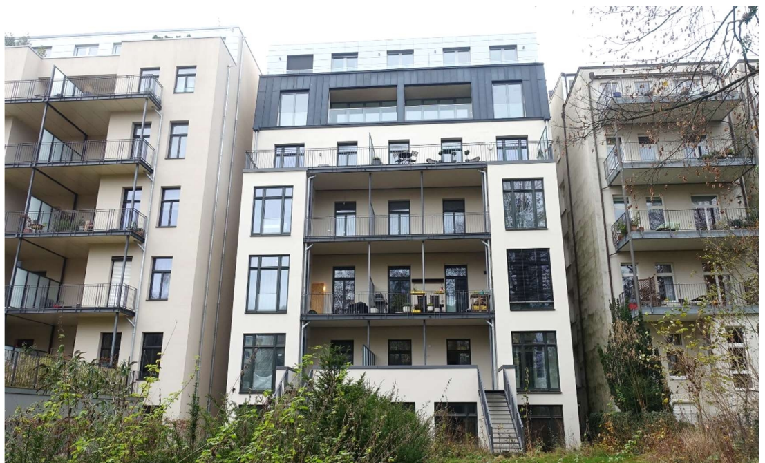
■ Straßen- und Gartenfassade
