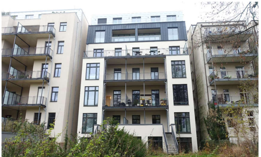
■ Straßen- und Gartenfassade
