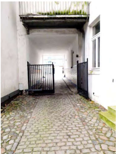
Bild 15: Bereich Hinterhof Hofausfahrt
