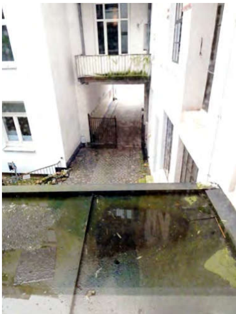
Bild 19: Blick aus dem Treppenhaus
