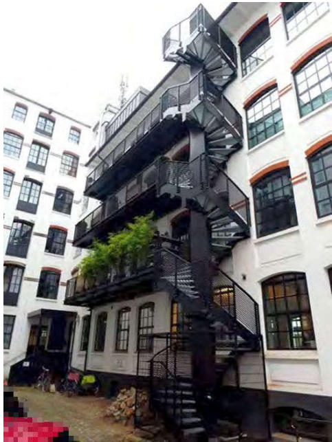
Bild 13: Bereich Hinterhof mit Treppenanlage (2. Rettungsweg)
