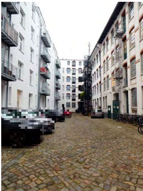
Bild 7: Blick in den Hinterhof
