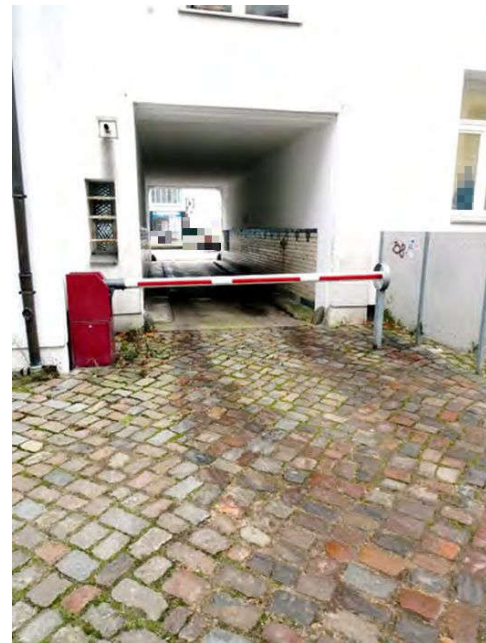
Bild 6: Bereich Toreinfahrt Hinterhof
