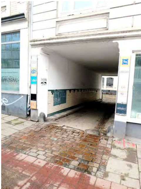
Bild 5: Bereich Toreinfahrt zum Hinterhof
