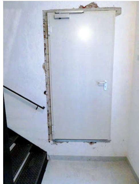
Bild 24: Treppenhaus Eingangsbereich Bewertungsobjekt
