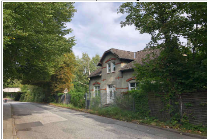
Bild 2: Straßenansicht Südwest, im Vordergrund Billbrookdeich 265
