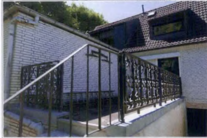
Bild 4: Ansicht Südost Ost: Anbau, unterkellerte Terrasse
