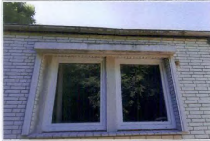
Bild 7: Ansicht Süd, Anbau
