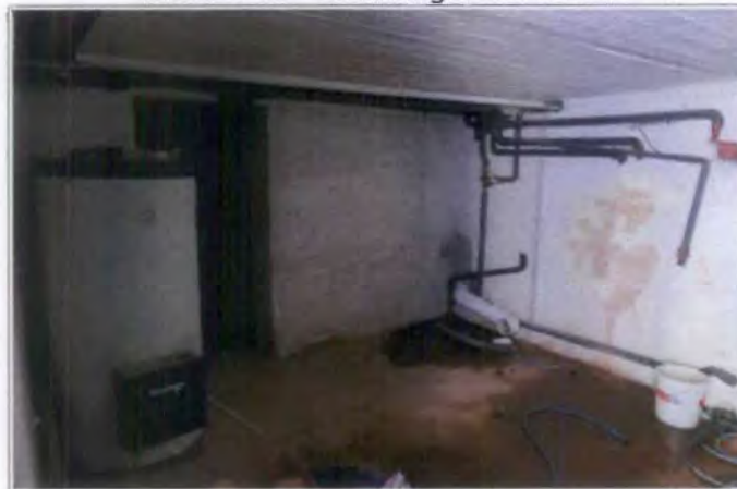
Bild 31: KG – ehemaliger Heizraum
