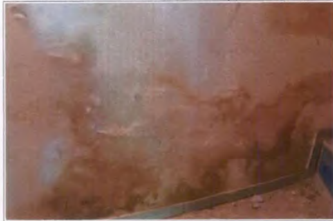
Bild 33: KG – Innenwand am Treppenaufgang
