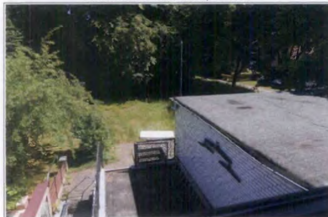
Bild 3: Ansicht Anbau, Garten
