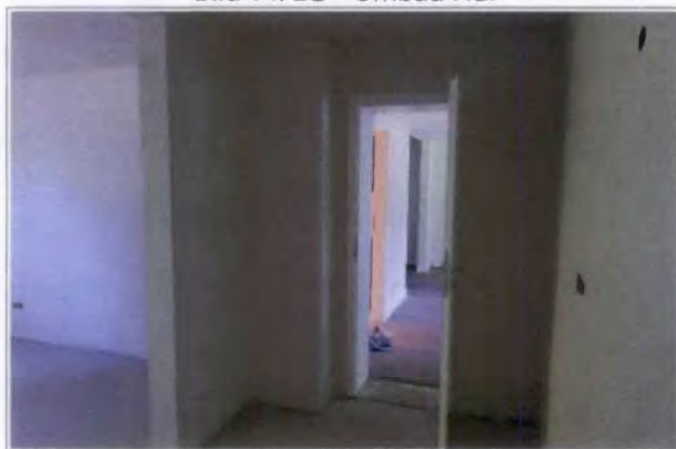
Bild 14: EG – Umbau Flur
