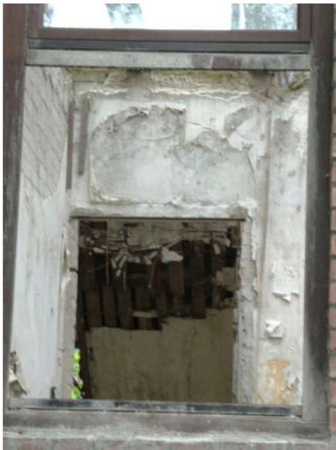
Bild 13: Situation Gebäude innen
