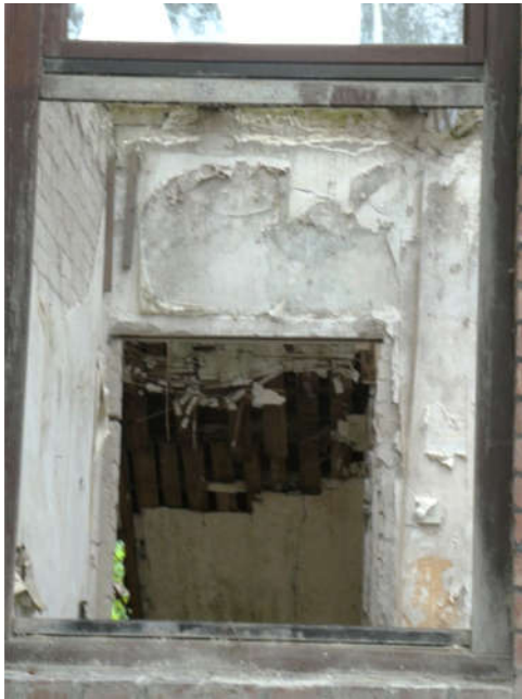
Bild 13: Situation Gebäude innen
