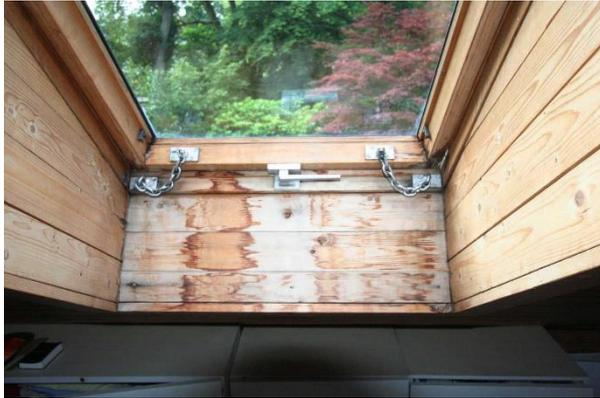
alter Wasserschaden am Dachflächenfenster im DG
