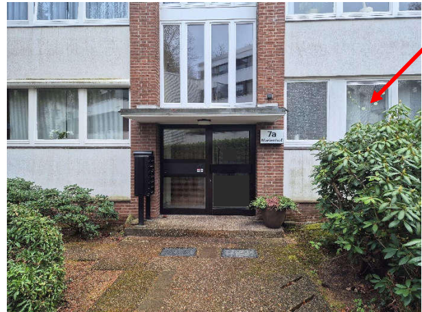
Eingangsbereich im Detail
