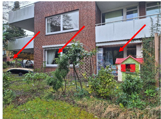
Gebäuderückseite im Detail
