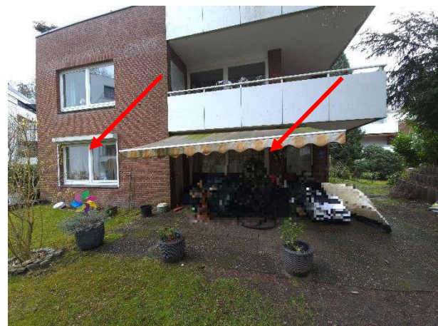
Terrasse im Detail (Westen)
