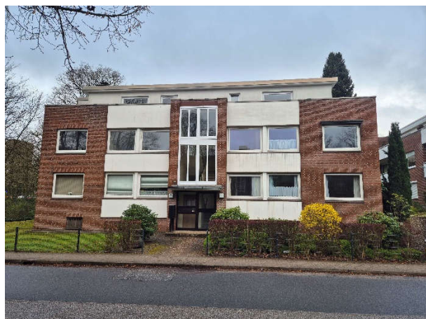
Gebäudevorderseite mit Hauseingang Nr. 7 (Osten)
