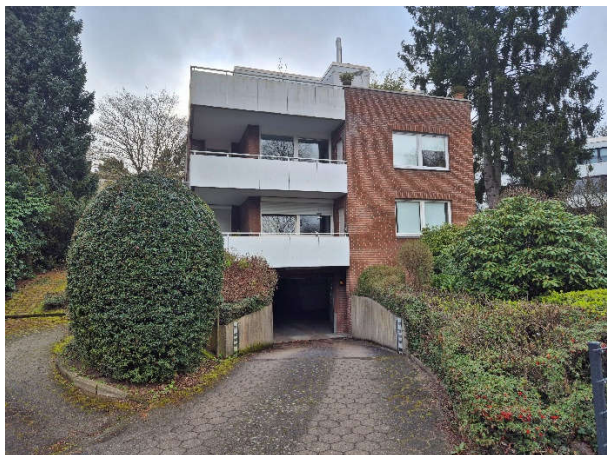
Garagenzufahrt an Ostseite von Gebäude Nr. 7a
