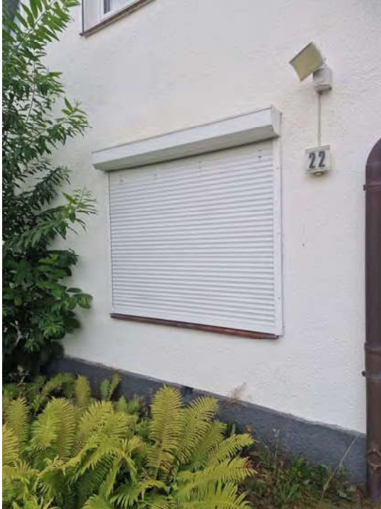
... Fenster mit Vorbaurolläden und weißen Lamellen
