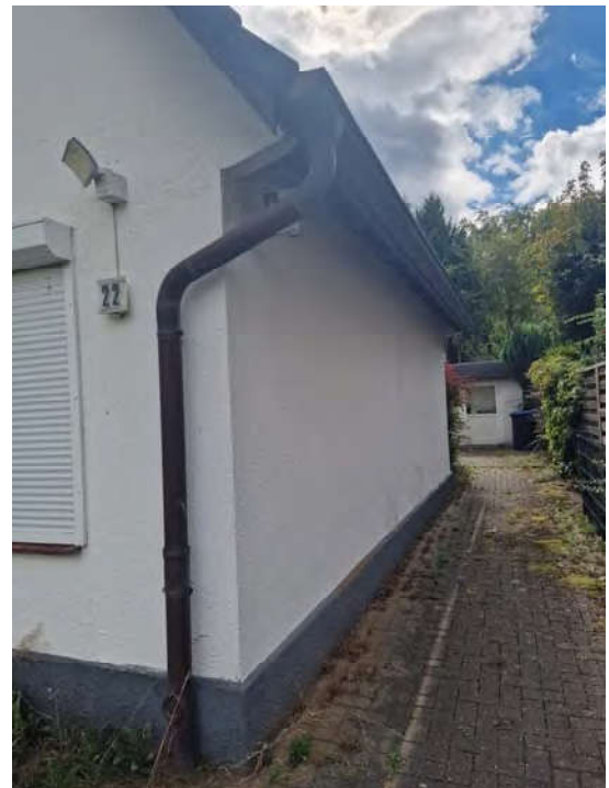
... mit seitlicher Zufahrt zur Grundstücksrückseite
