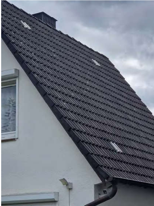
... hölzerne Satteldachkonstruktion mit Dacheindeckung aus
