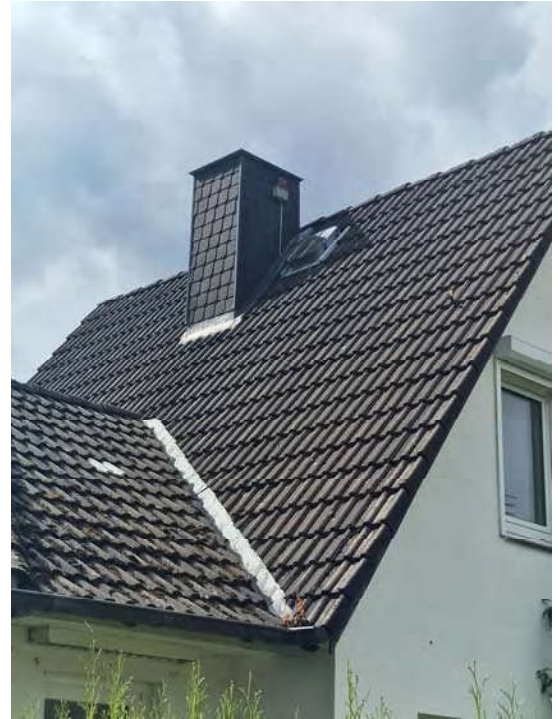
... hölzerne Satteldachkonstruktion mit Dacheindeckung aus
