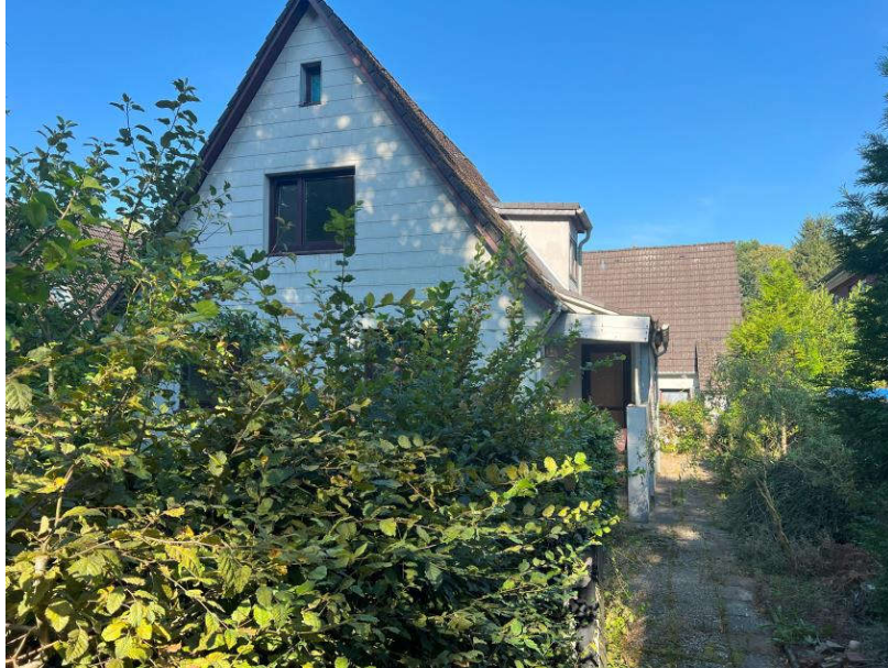
Ansicht Straßenseite Südosten (WE Nr. 1)
