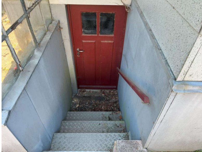
Kelleraußentreppe und Tür (WE Nr. 1)
