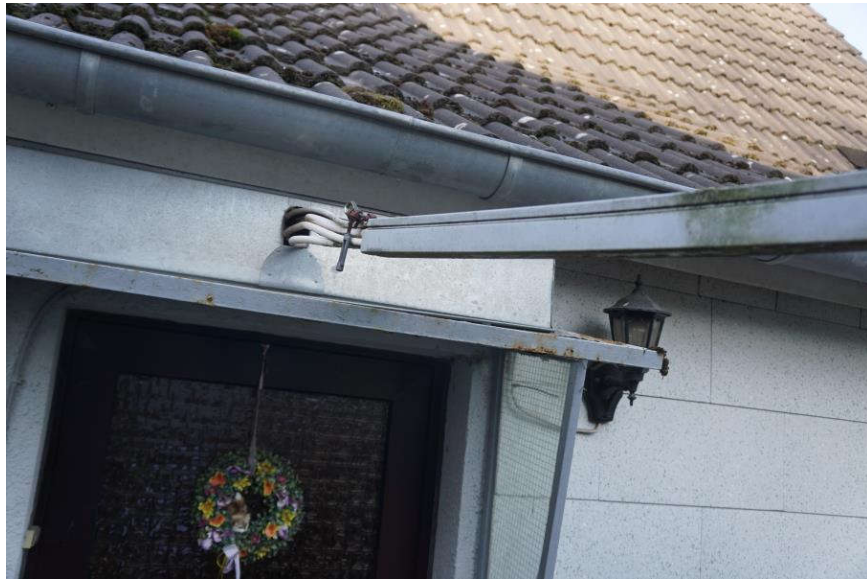
Detail Hauseingang mit Dachdeckung und Elektrik (WE Nr. 2)
