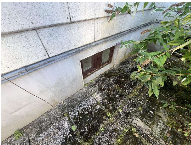
Detail Fassade Kelleraußenfenster WE Nr. 1
