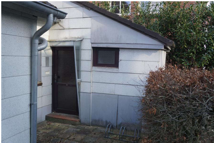
Hauseingang Anbau (WE Nr. 2)
