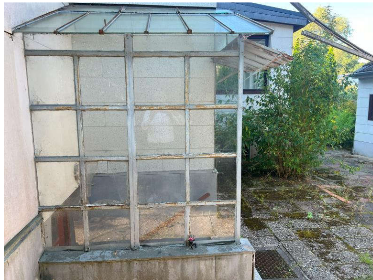
Überdachung Kelleraußentreppe (WE Nr. 1)
