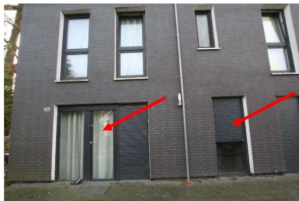
Eingangs- und Terrassenbereich (Norden)
