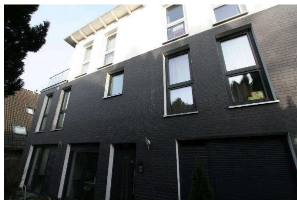
Gebäuderückseite mit Hauseingang Süd-Ost-Seite
