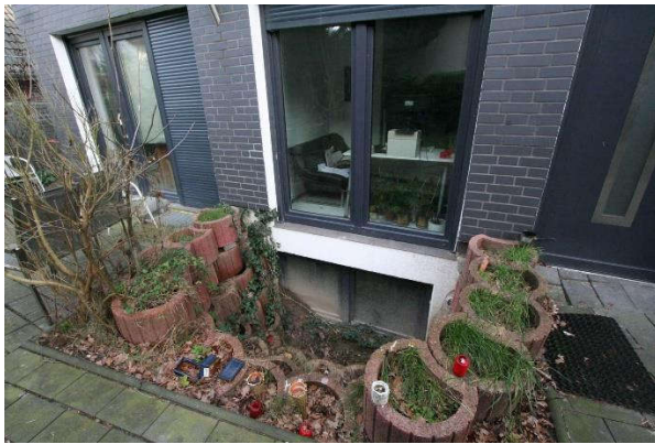
Ort für geplante Außenkellertreppe zum Heizungskeller
