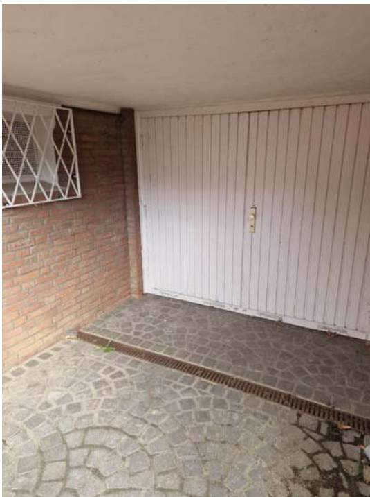
... Zufahrt zur Kfz-Kellergarage
