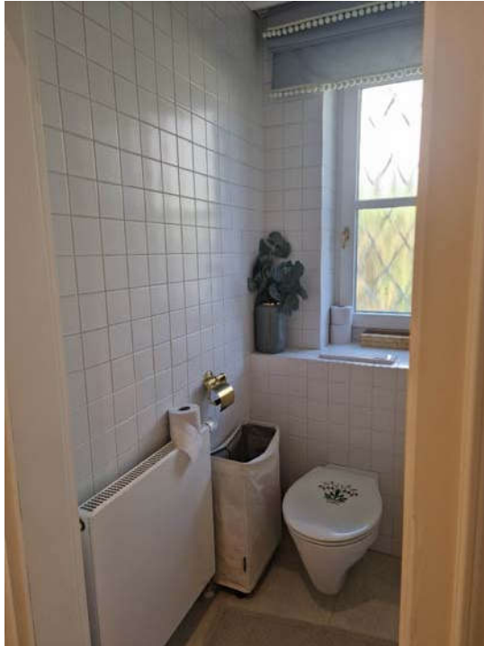
... wandhängendem Tiefspüler mit eingebautem Reservoir
