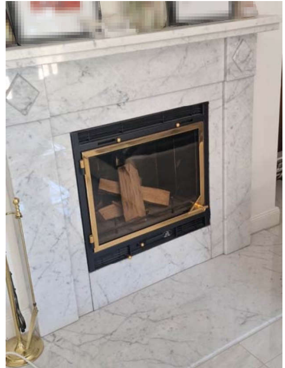
...Kamin im Wohnzimmer (als offene Brennstelle mit Zulassung für stundenweise Nutzung)
