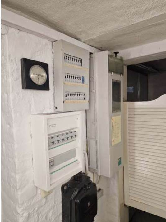
... ELT mit FI-Kippschalter-Sicherungen
