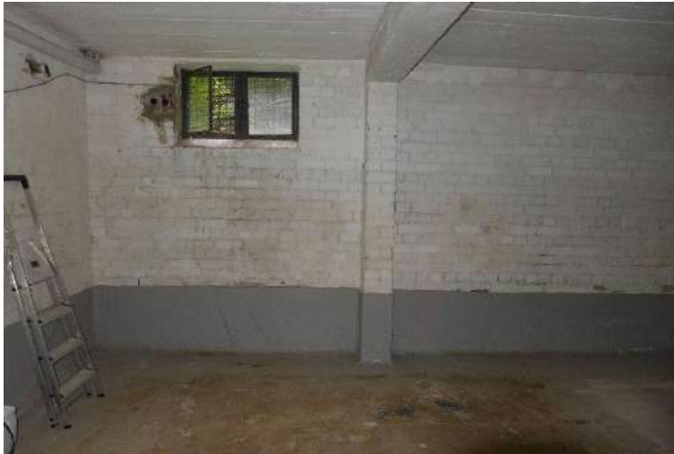
19. Kellerraum zur Wohnung
