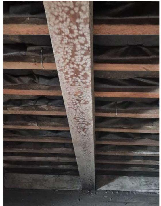
... mit überwiegend flächigem Pilzbefall an tragenden Hölzern (Stile, Pfetten und Sparren) des hölzernen Dachstuhls
