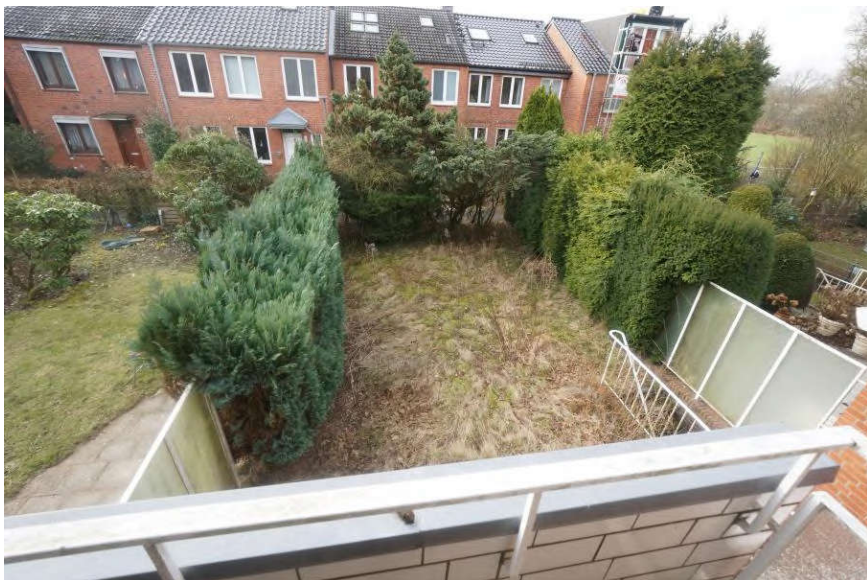
Blick vom Obergeschoss in den Garten (Süden)
