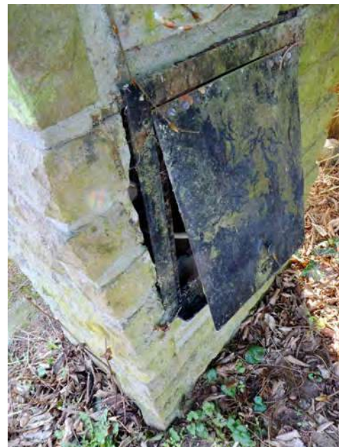
Bild 20: Situation Briefkasten Auffahrtsbereich
