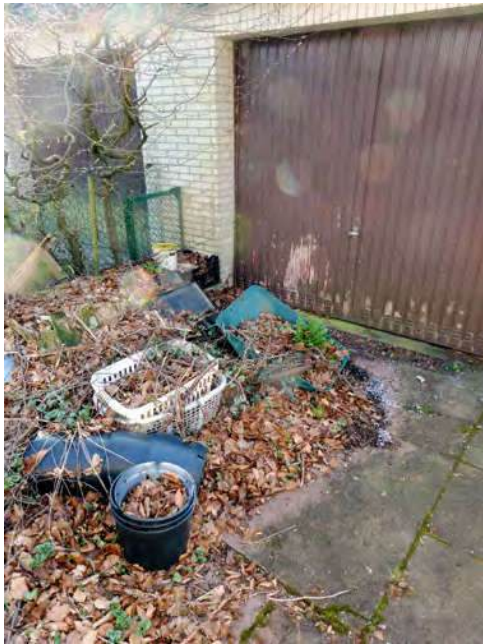
Bild 13: Situation Nebengebäude Garage Bereich Einfahrt
