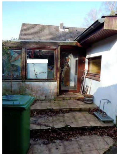
Bild 8: Teilansicht Wohnhaus mit Anbau (rückwärtig)
