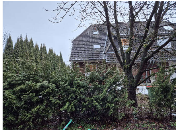
Vorderseite Doppelhaushälfte (Westen)
