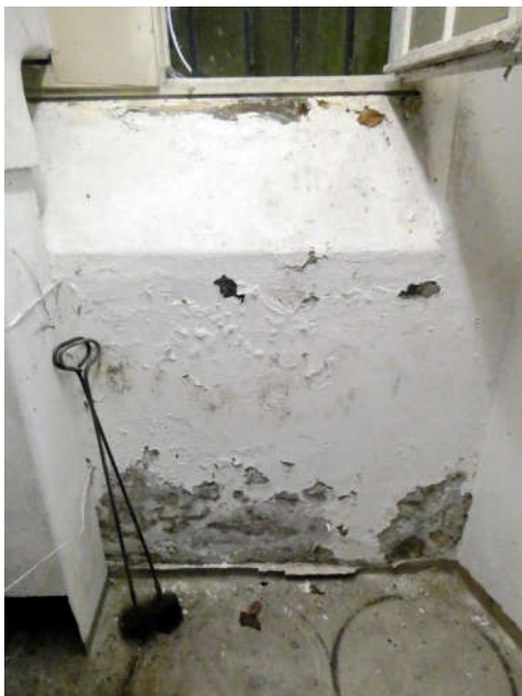
Bild 99: Kellerraum / Feuchtigkeitsschaden
