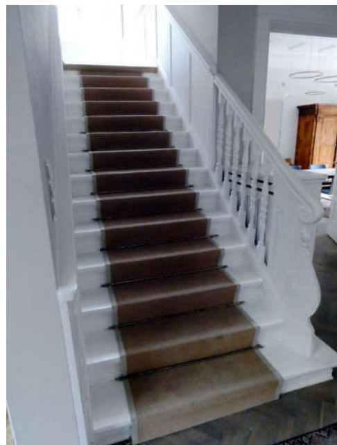
Bild 48: EG Treppe in das OG
