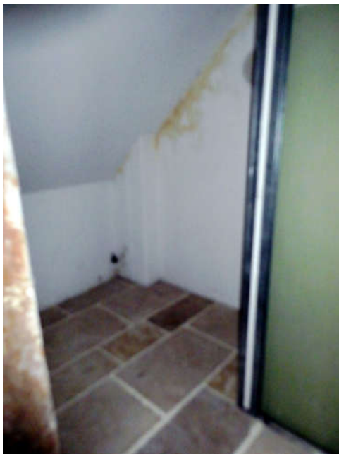
Bild 81: DG Sauna (unfertig)
