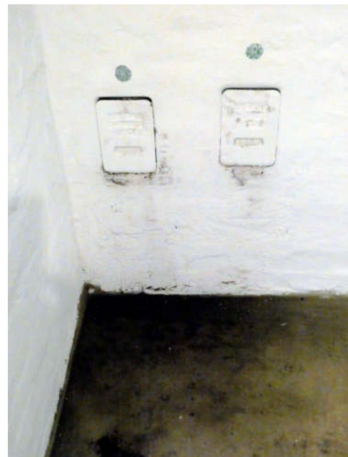
Bild 112: Keller Feuchtigkeitsschaden
