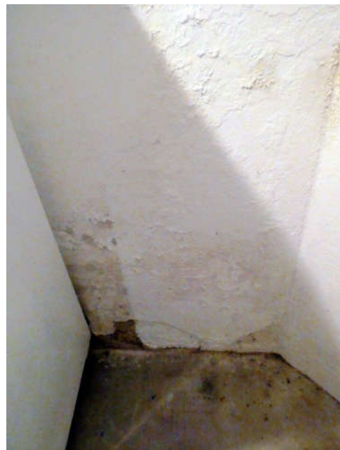
Bild 104: Keller Feuchtigkeitsschaden
