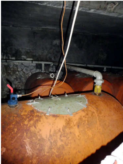
Bild 101: Keller Heizöltanks
