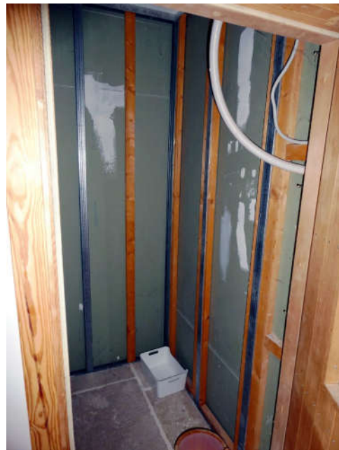
Bild 82: DG Sauna (unfertig)
