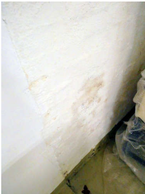
Bild 117: Keller Feuchtigkeitsschaden
