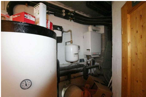
Gastherme und Warmwasserspeicher
