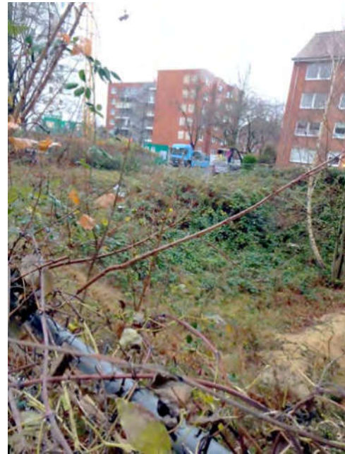
Bild 10: Blick in die Baugrube
