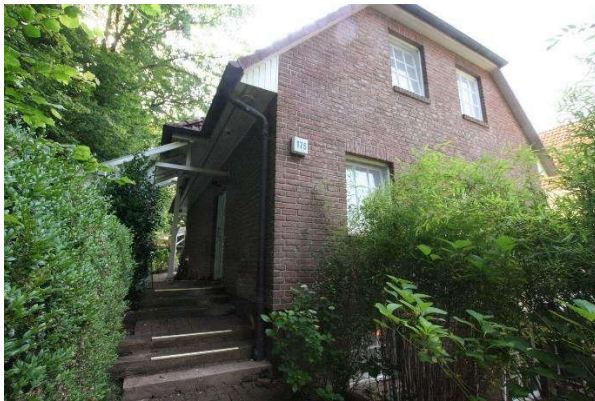
Gebäudevorderseite mit Eingangsbereich (Nord-Westen)
